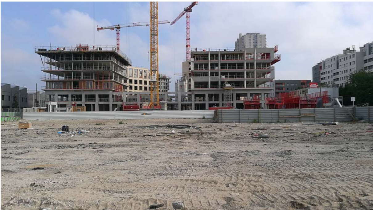
4. Vue depuis le site vers le nord, les chantiers en cours, la tour de logements ICF la Sablière et les immeubles de la rue de la Chapelle
