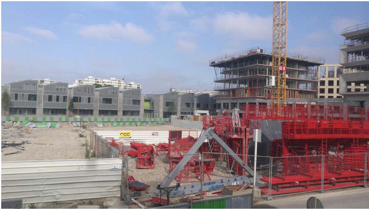
1. Vue sur le site depuis l'est, à gauche la base logistique et immeubles émergeant situés de l'autre côté des voies ferrées, à droite chantier du lot G en cours
