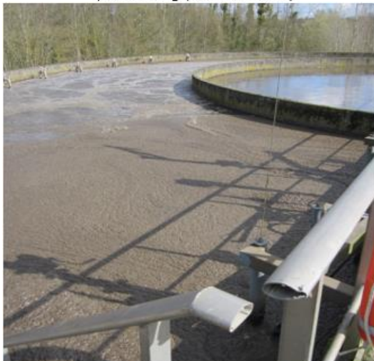
Vue du dessus du bassin d'aération en fonctionnement (Bassin biologique n°1 : 6000 m 3 )
