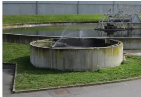
Clarificateur (diamètre : 35 m)
