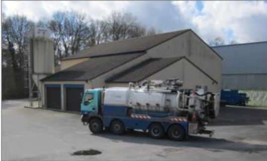
Poste de répartition entre les bassins d'aération Et stockage du Chlorure ferrique
