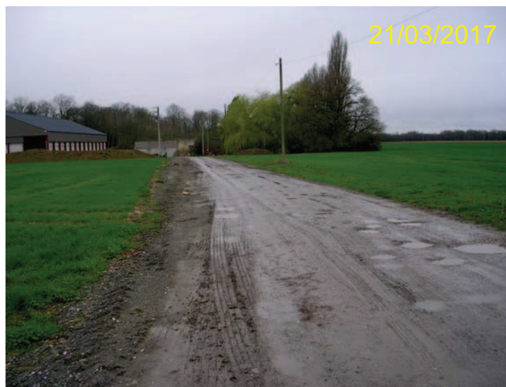
1. Vue générale du site d'implantation
