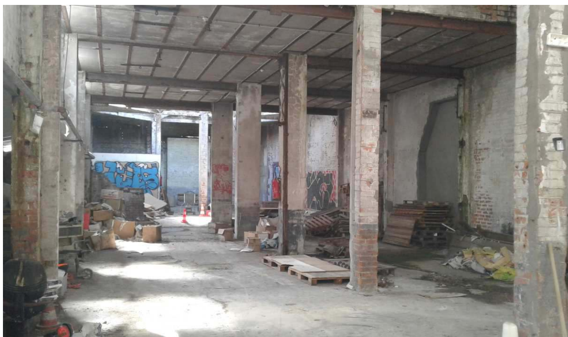
Photographie 27 : Partie Sud de l'usine EIF (Source : BURGEAP, 03/05/18)
