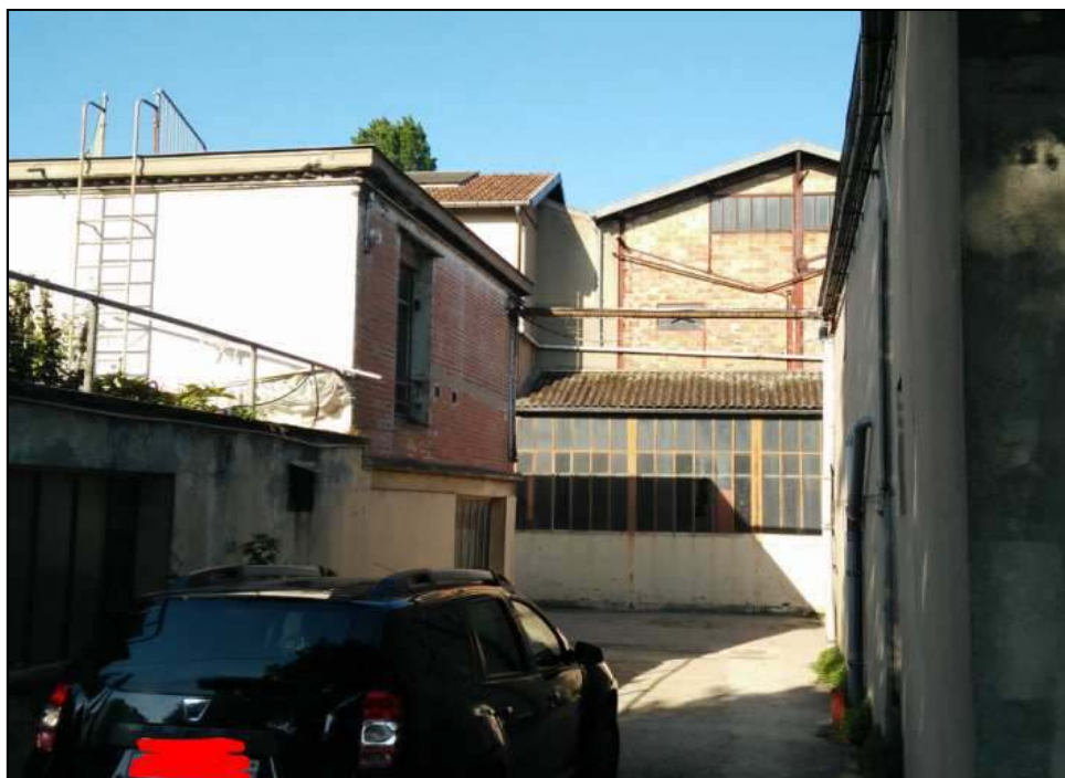
Photographie 16 : Usine EIF (Source : BURGEAP, 03/05/18)
