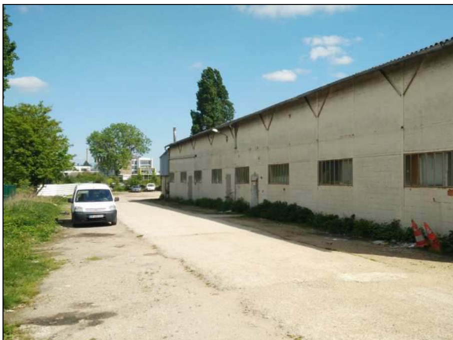
Photographie 24 : Hangar à l'Ouest du site, accessible vue depuis le parking (Source : BURGEAP, 03/05/18)
