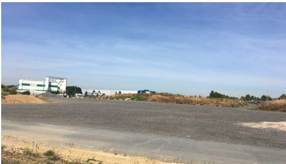
Vues photographiques rapprochées de la plateforme Ouest « centrales d'enrobage » (COLAS IDFN, 17/09/2018)
