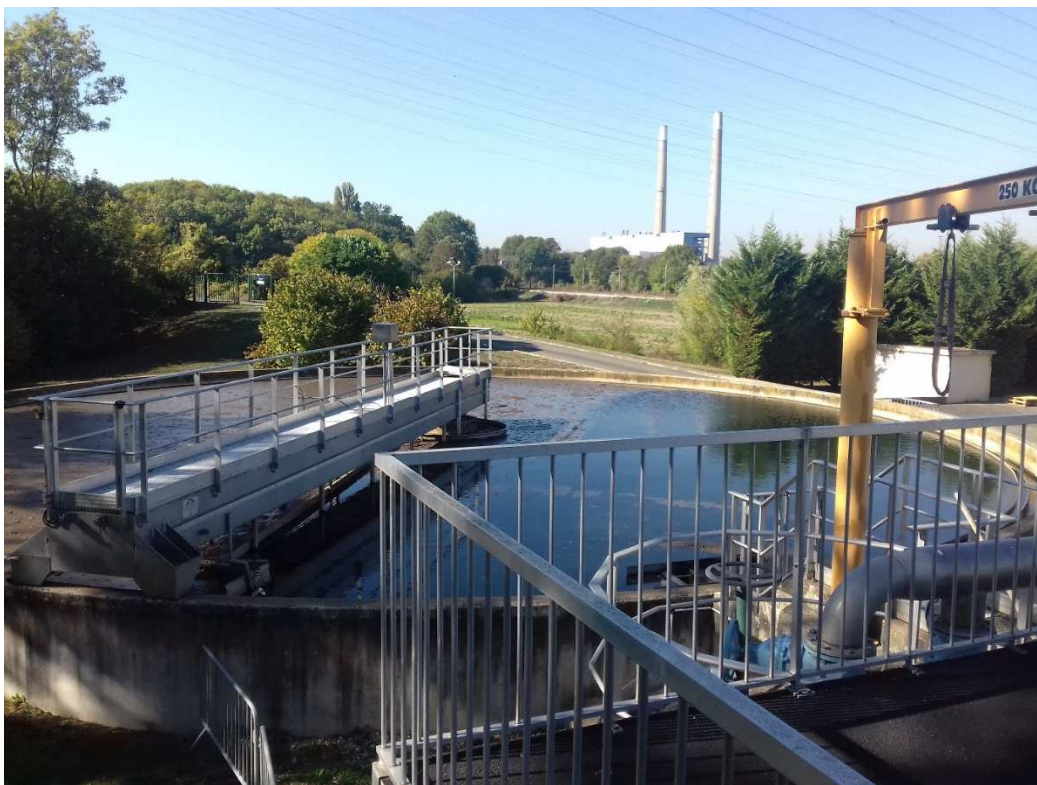
Vue du clarificateur
