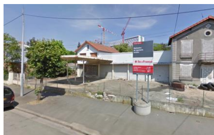
Site du projet, prise de vue depuis l'Avenue de la République, mai 2011 ; Google Street View
