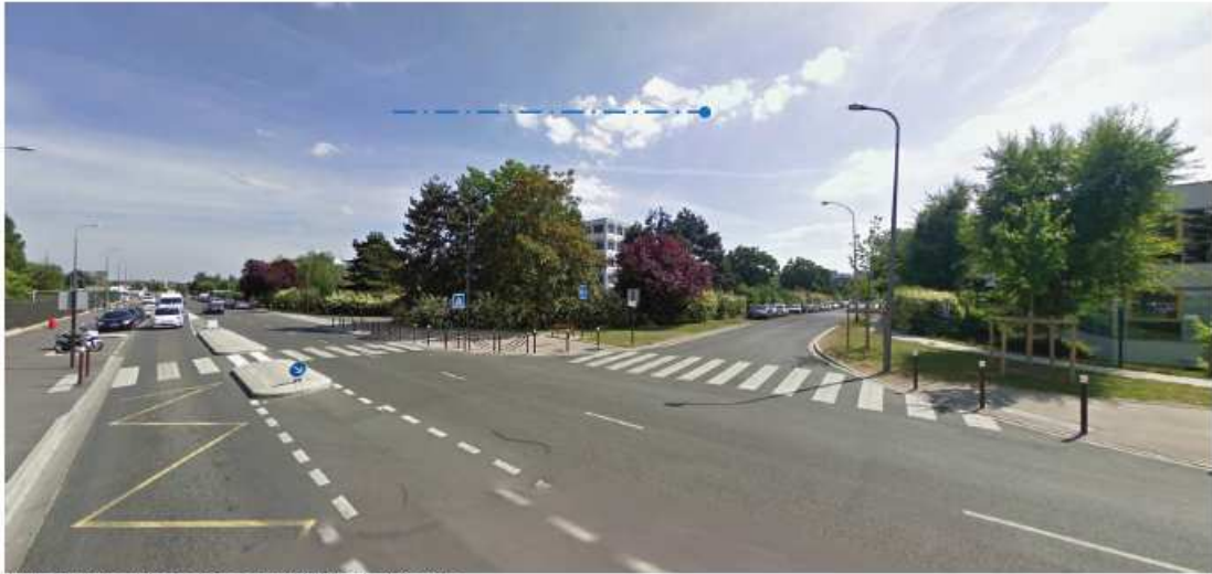
Vue 1 : Rue Marcel Dassault/Allée Latécoère
