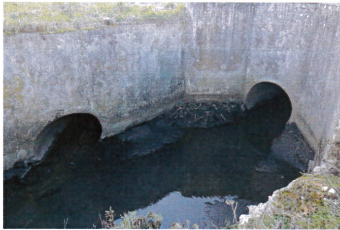
FIGURE 10 : EXUTOIRE DES BASSINS DANS LE ROUILLON
