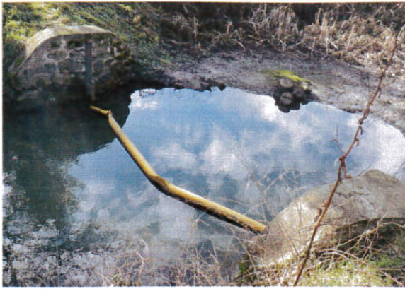
FIGURE 5 : BARRIERE ANTI-POLLUTION ENTRE LE DESSABLEUR ET LE BASSIN 1
