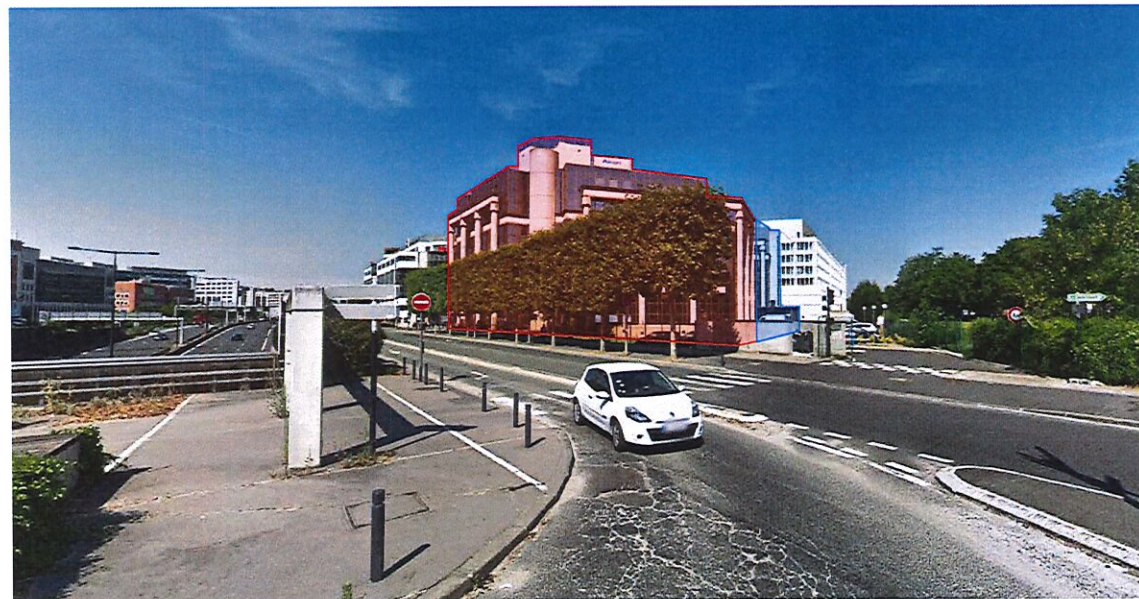
Vue 1 _ bâtiment existant depuis le Carrefour National
