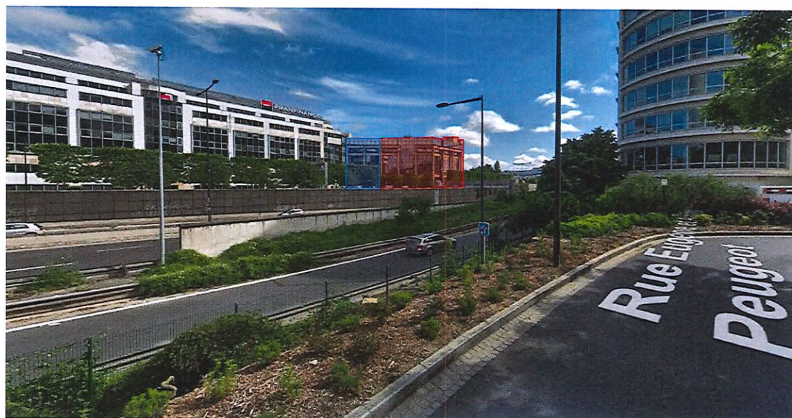
Vue 4 _ bâtiment existant depuis la Rue Eugène et Armand Peugeot
