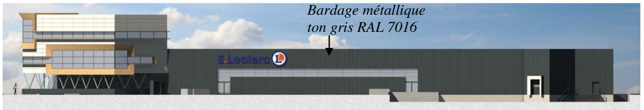
Le bardage métallique de la façade arrière existante sera repeint dans une teinte de gris clair RAL 7047. La partie en extension sera habillée d'un bardage métallique vertical de ton gris anthracite RAL 7016
