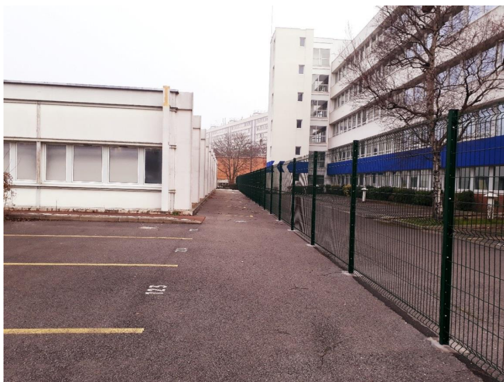
Photographie 6 : Limite Est du site : Séparation entre les parcelles 121 et 122
