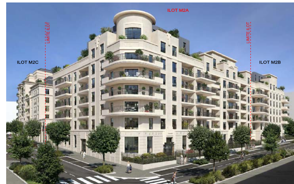
Vue à l'angle de la rue des Docks et de la rue Pablo Picasso
