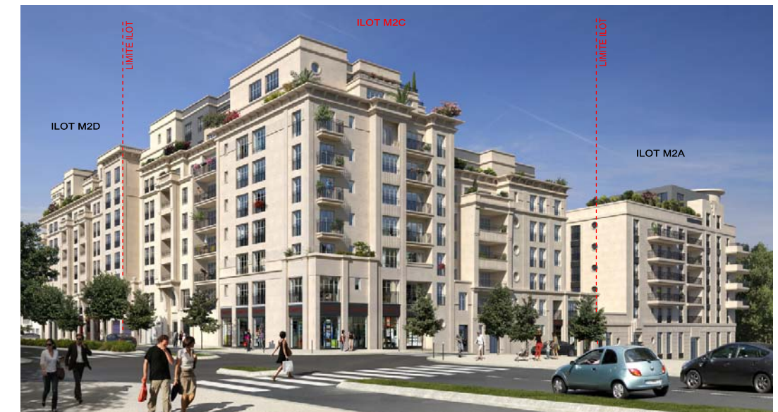
Vue à l'angle de la rue des Docks et de la rue Simone Veil
