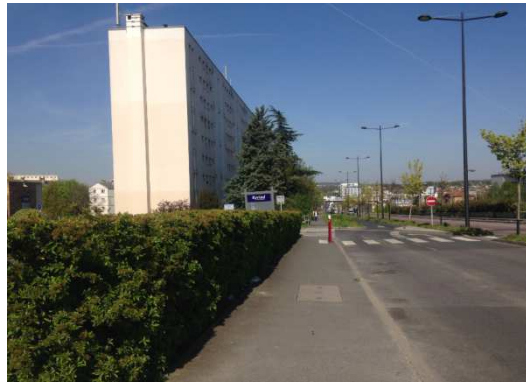
5 – Voiries et chemin piéton situés à l'arrière du site
