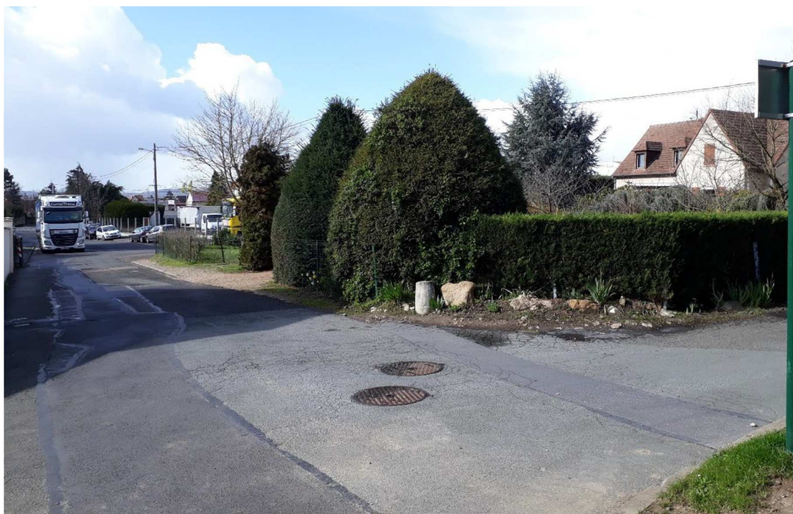
(27) Photographie 24 : Vue de la rue des Sablons, depuis Rue Amédée Dutard
