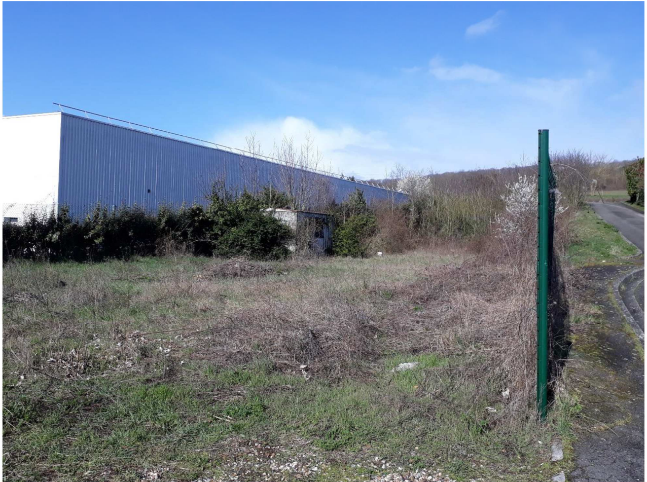
(23) Photographie 19 : Vue de du flanc Est du supermarché casino
