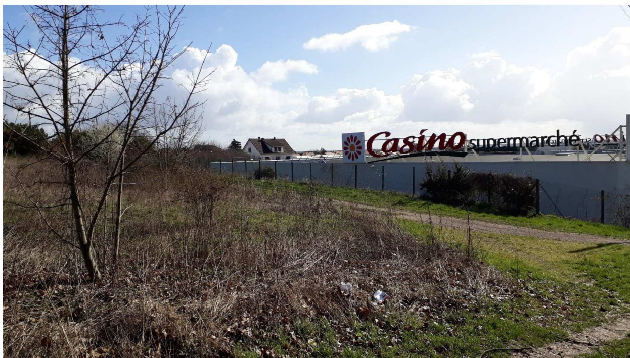
(18) Photographie 14 : Vue de la partie Nord du site et du supermarché Casino, depuis l'Avenue Victor Schoelcher
