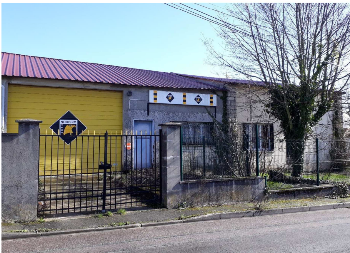
(24) Photographie 20 : Vue du garage Norisko
