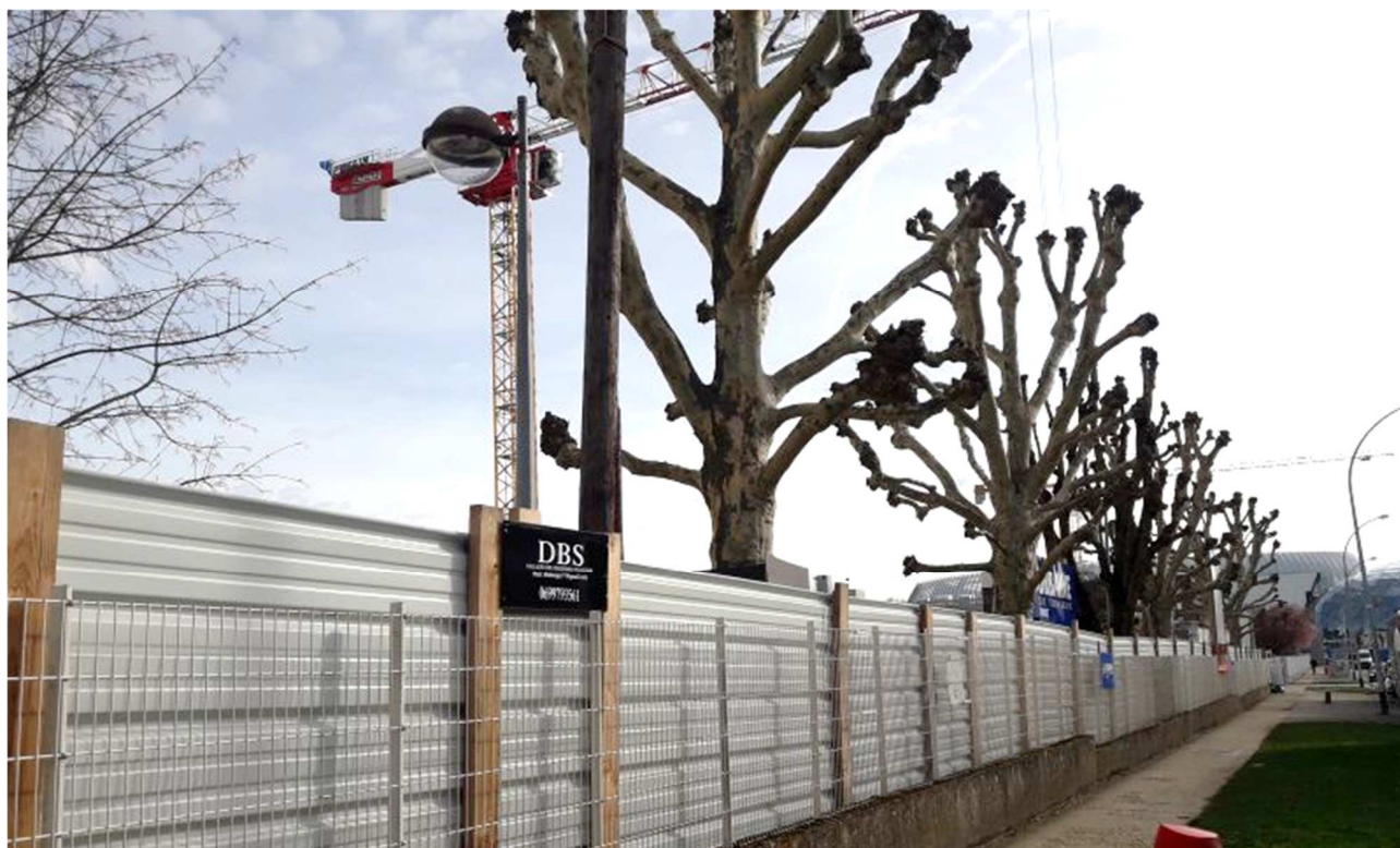
Photographie 3 : Vue du chantier du nouveau siège de Schindler
