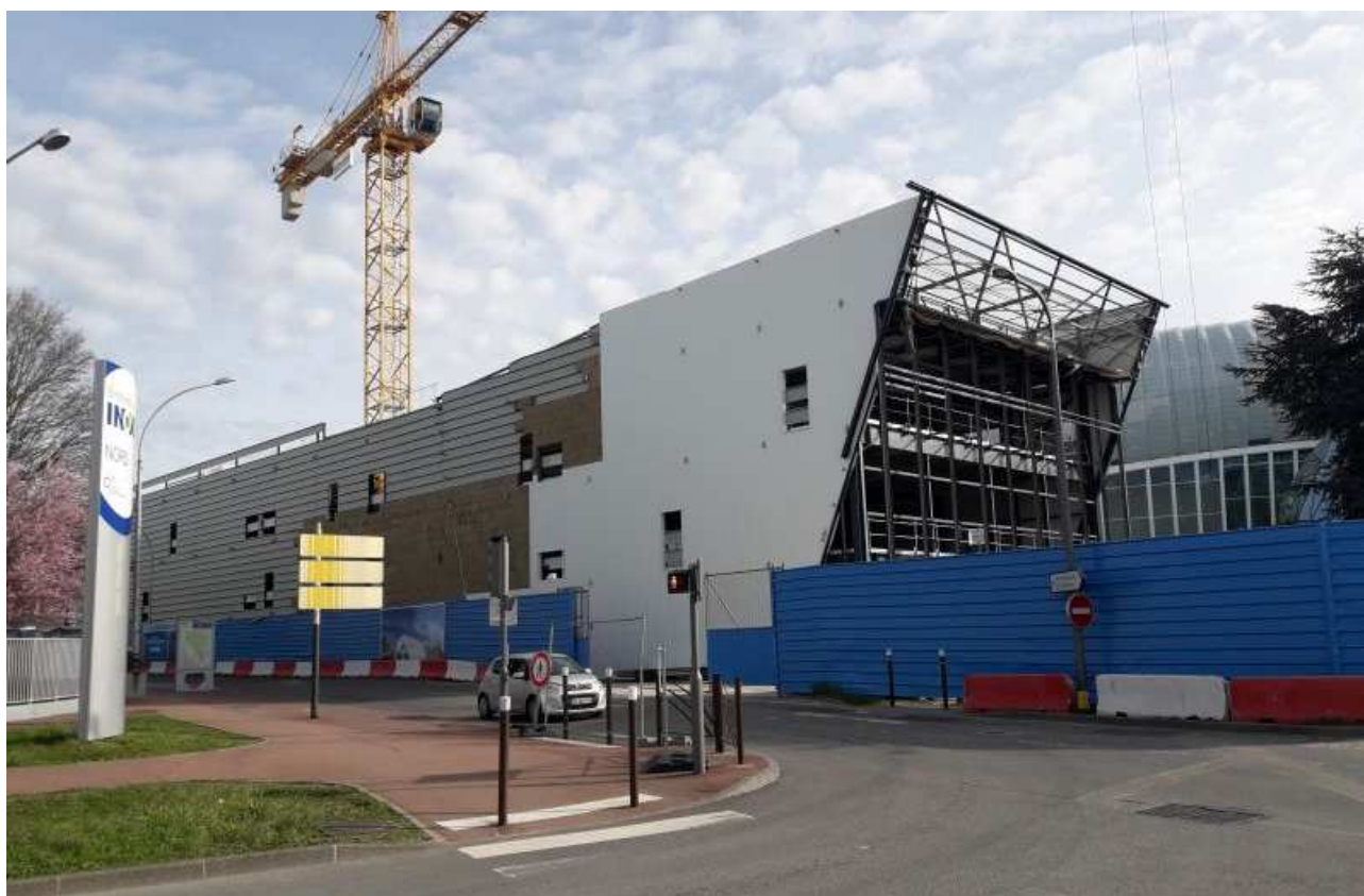
Photographie 14 : Vue du chantier sis avenue de l'Europe
