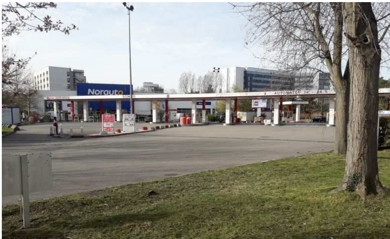
Photographie 15 : Vue de la station-service sise rue Dewoitine
