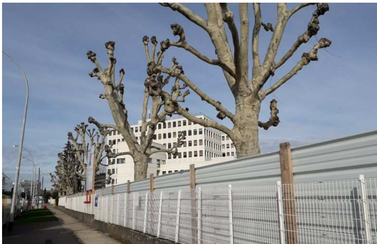
Photographie 4 : Vue du site et du chantier de la nouvelle siège de Schindler depuis la rue Dewoitine
