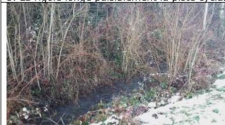
4. La rigole est encombrée par des broussailles et autres embâcles.
