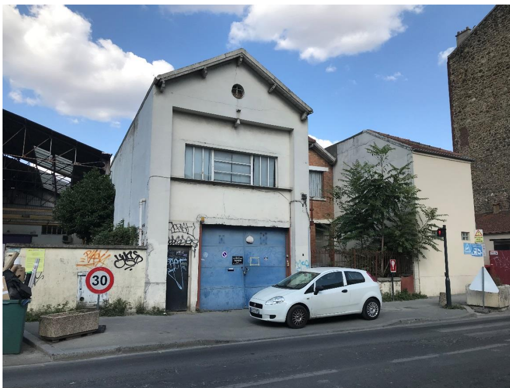
Photographie 11 : Locaux techniques attenants
