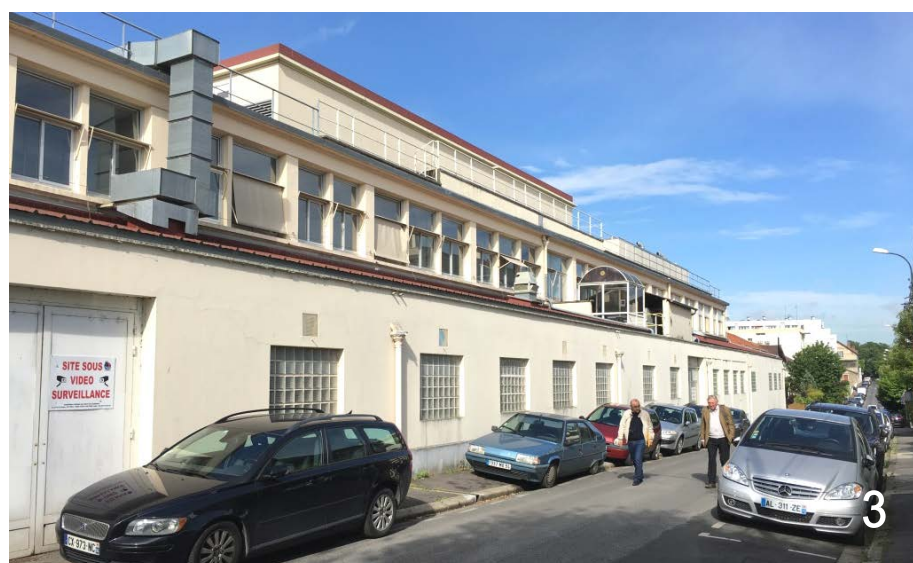
Vue sur les bâtiments en bordure Nord-Ouest du site, le long de la rue du Dauphiné
