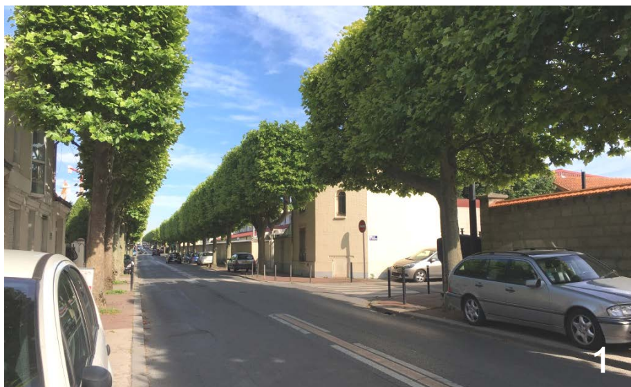
Vue sur les bâtiments situés à l'angle Sud-Est du site, au croisement de l'avenue de Condé et de la rue de Normandie
