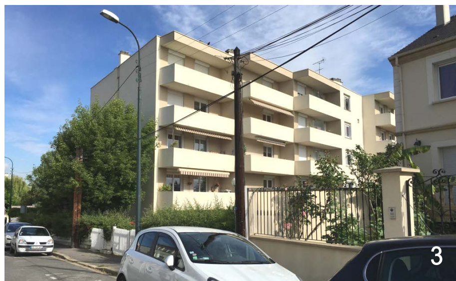
Vue sur les bâtiments environnants de la rue du Dauphiné
