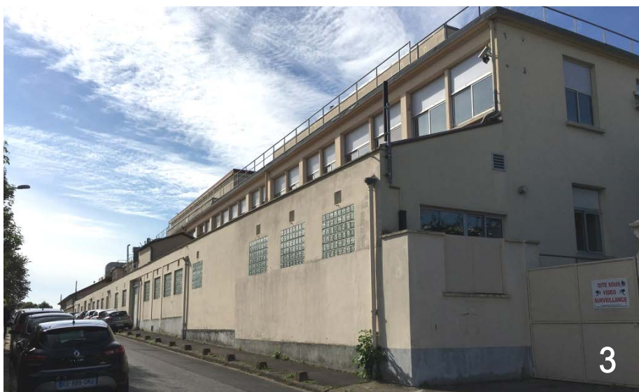
Vue sur les bâtiments situés à l'angle Nord-Ouest du site, au croisement de la rue du Dauphiné et de la rue de Savoie
