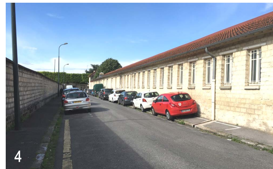
Vue sur les bâtiments situés le long de la rue de Normandie, en frange Est du site
