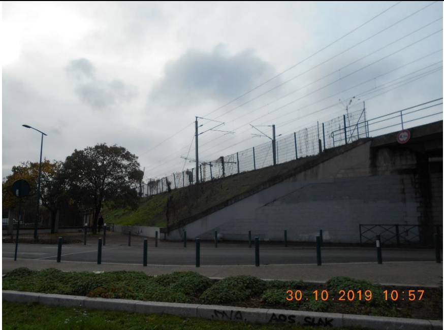
17 : passage de la ligne RER rue des Caboeufs
