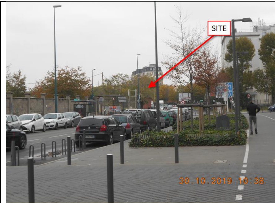
7 : vue depuis l'avenue Louise Michel depuis le sud-ouest
