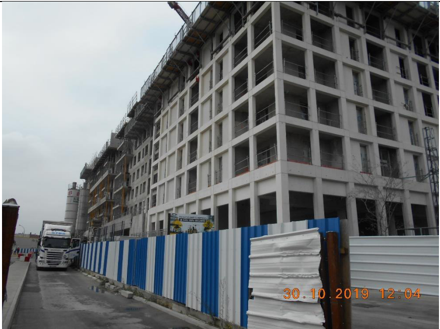
24 : construction d'un bâtiment d'habitat, avenue des Grésillons à Asnières-sur-Seine
