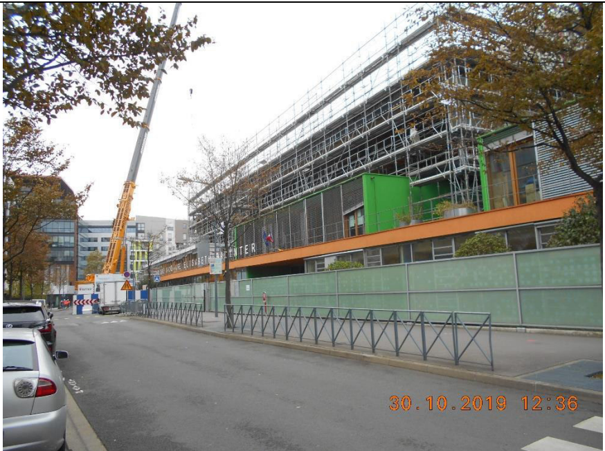
26 : Ecole Elisabeth Badinter à Asnières-sur-Seine (travaux d'extension)
