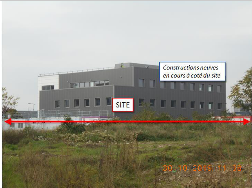
6 : Vue du site vers l'ouest
