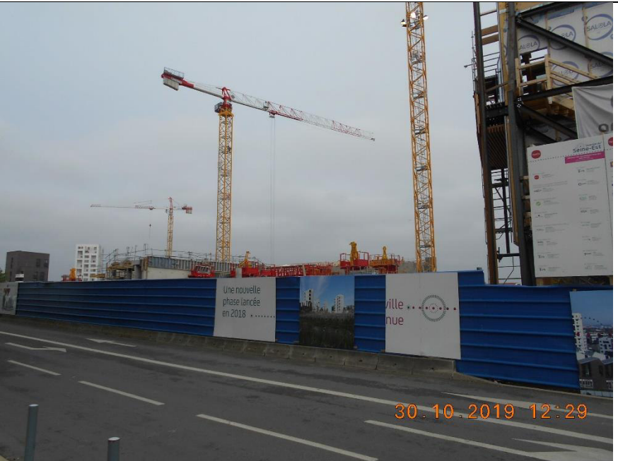
25 : construction du Quartier de Seine ouest, à Asnières-sur-Seine (2 000 logements)
