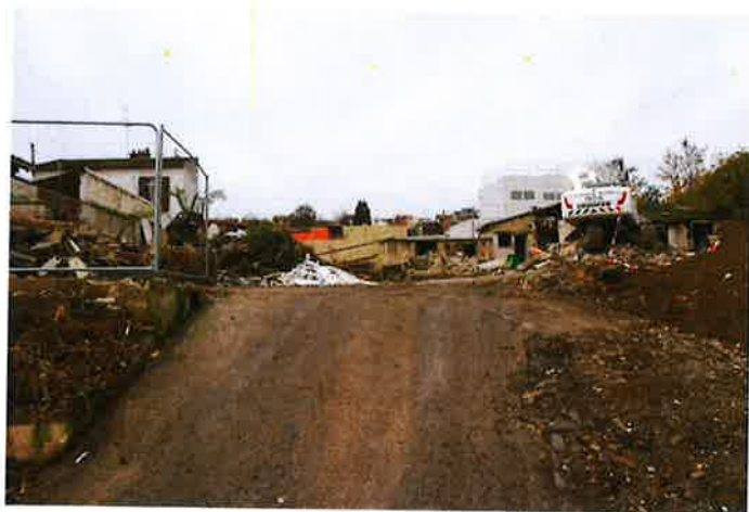
Photo 5 : démolitions en cours à l'intérieur de l'îlot D (partie centrale) vues depuis la rue Coquelin vers l'ouest.
