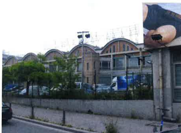
2 – Façade orientale des docks vue en direction du sud-ouest.
