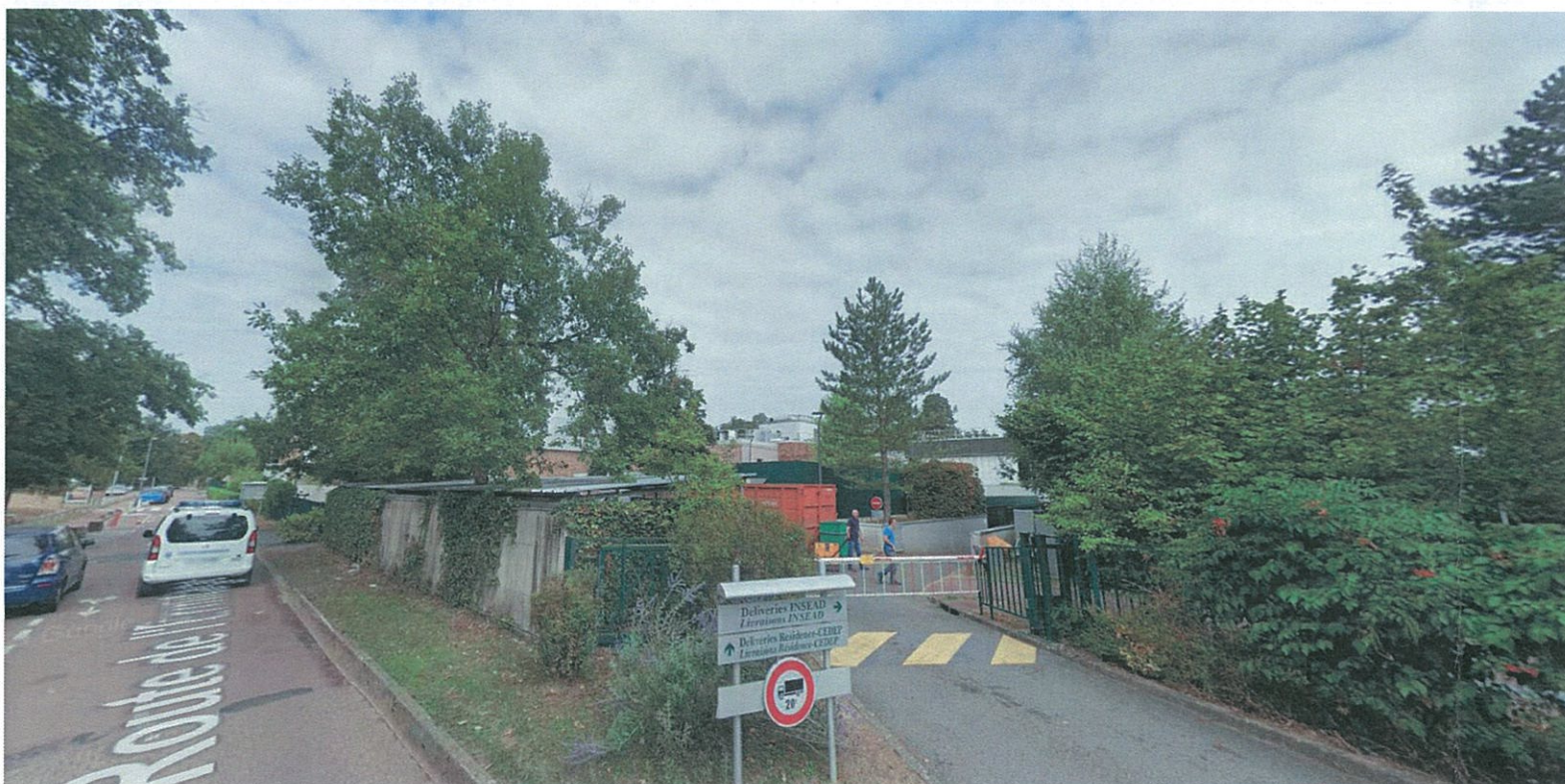
VUE 04 - Paysage lointain : depuis la Route de l'Ermitage, vue sur l'entrée de la zone de livraison où se situera le futur bâtiment technique au premier plan, et sur l'angle des façades Est et Sud du futur bâtiment MBA à l'arrière plan
