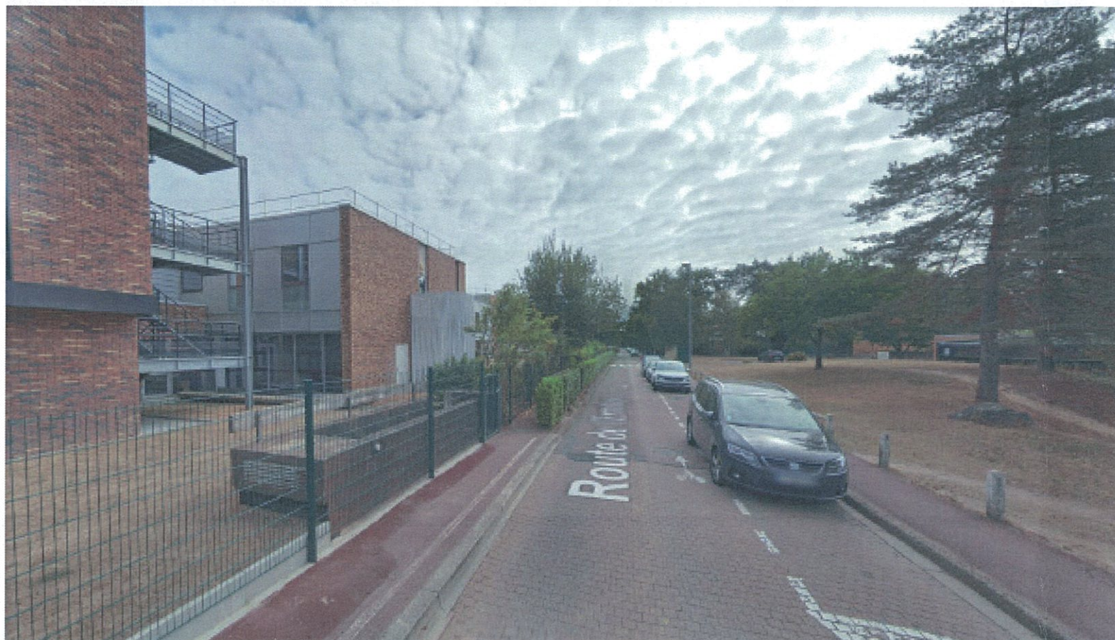
VUE 03 - Paysage proche : depuis la Route de l'Ermitage, montrant la façade Sud du futur bâtiment MBA après la démolition des bâtiments existants à gauche de la route sur la photo ci-dessus
