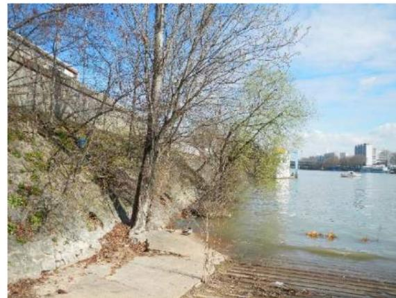
Fissure, pierres manquante et développement de végétation dans le perré
