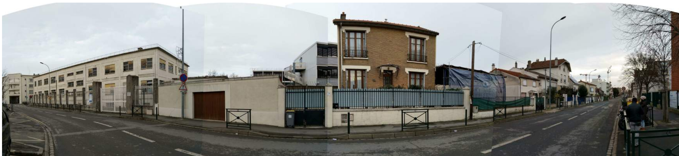
Photo A : depuis le réfectoire de l'école primaire situé rue Jean Marin Naudin (avant la démolition des bâtiments 141 et 142)
