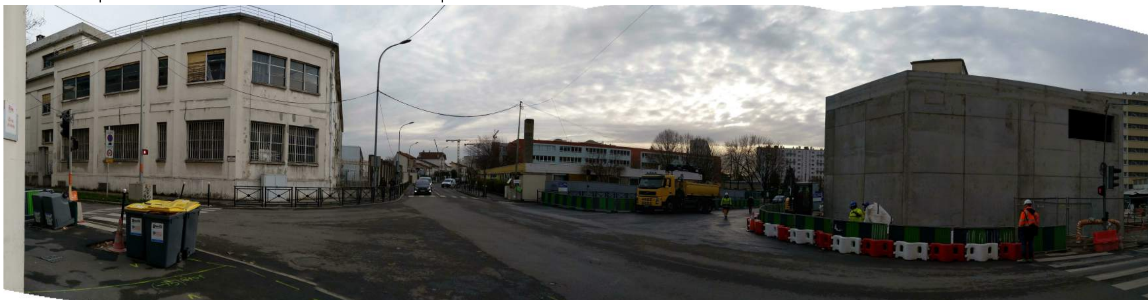
Photo C : depuis l'entrée du bâtiment situé 25 rue Jean Marin Naudin (avant la démolition des bâtiments 141 et 142)
