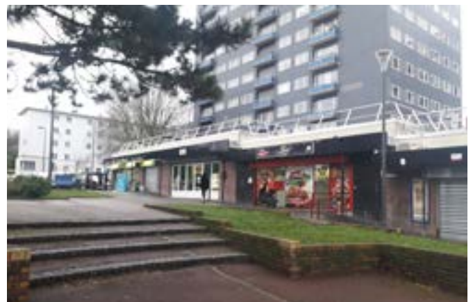
D - Centre commercial à l'ouest du site
