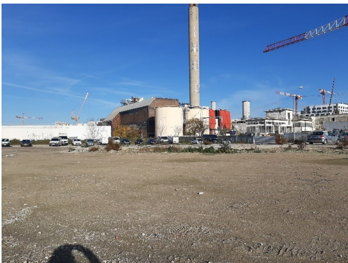
Photo 7 : Rue Ardoin depuis le centre de l'îlot (novembre 2019)
