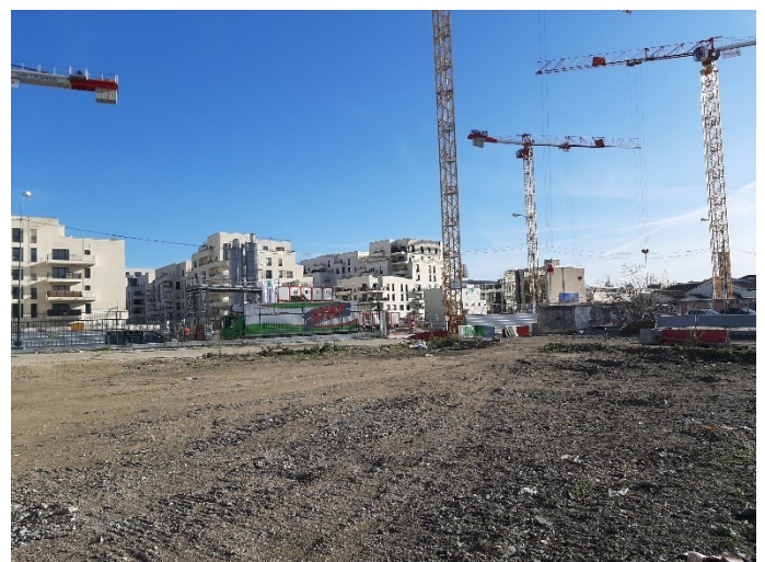
Photo 8 : Rue Ardoin depuis le centre de l'îlot (novembre 2019)
