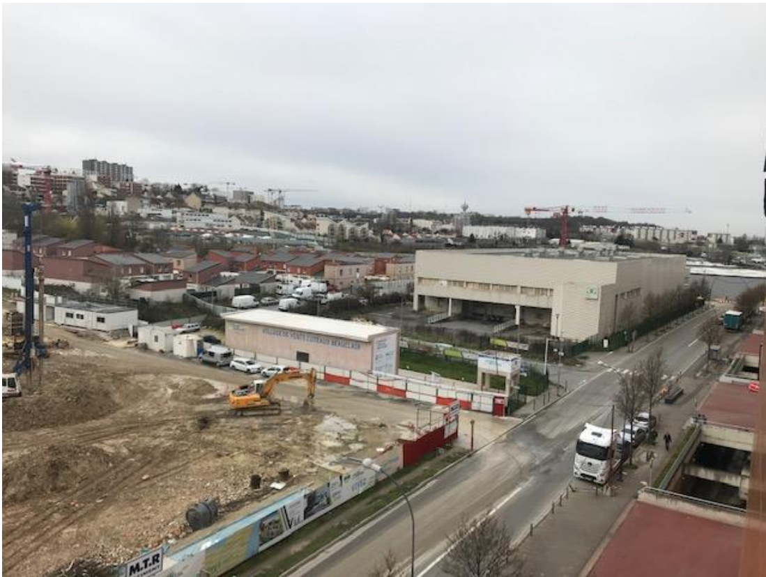
Photo 1. Vue de l'entrepôt Alinéa depuis le toit de DOMUS (28/02/2020)
