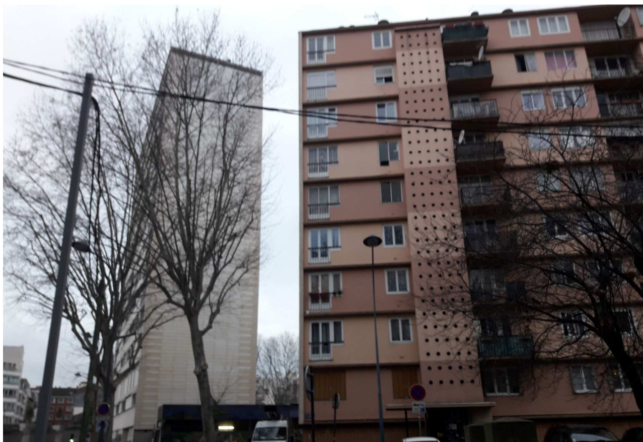
Photographie 8 : Vue du site depuis la Rue Gabriel Péri
