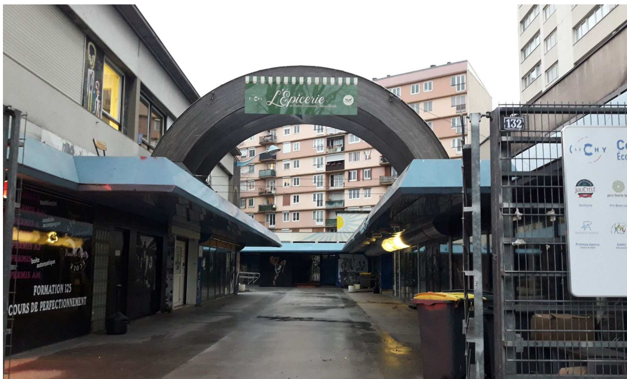
Photographie 3 : Vue de l'entrée du Centre Léon Blum depuis la Rue Martre
