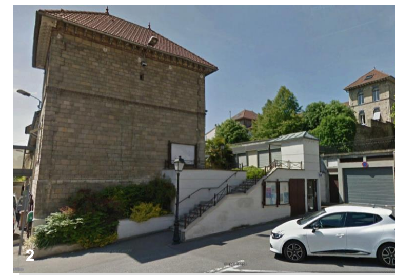
Vue sur les locaux des services municipaux à l'arrière de la Mairie
