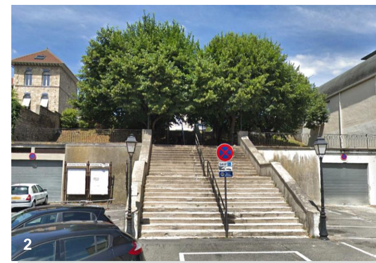
Vue sur les escaliers joignant les parkings sis Place du Général Leclerc et rue Arnould Crapotte
