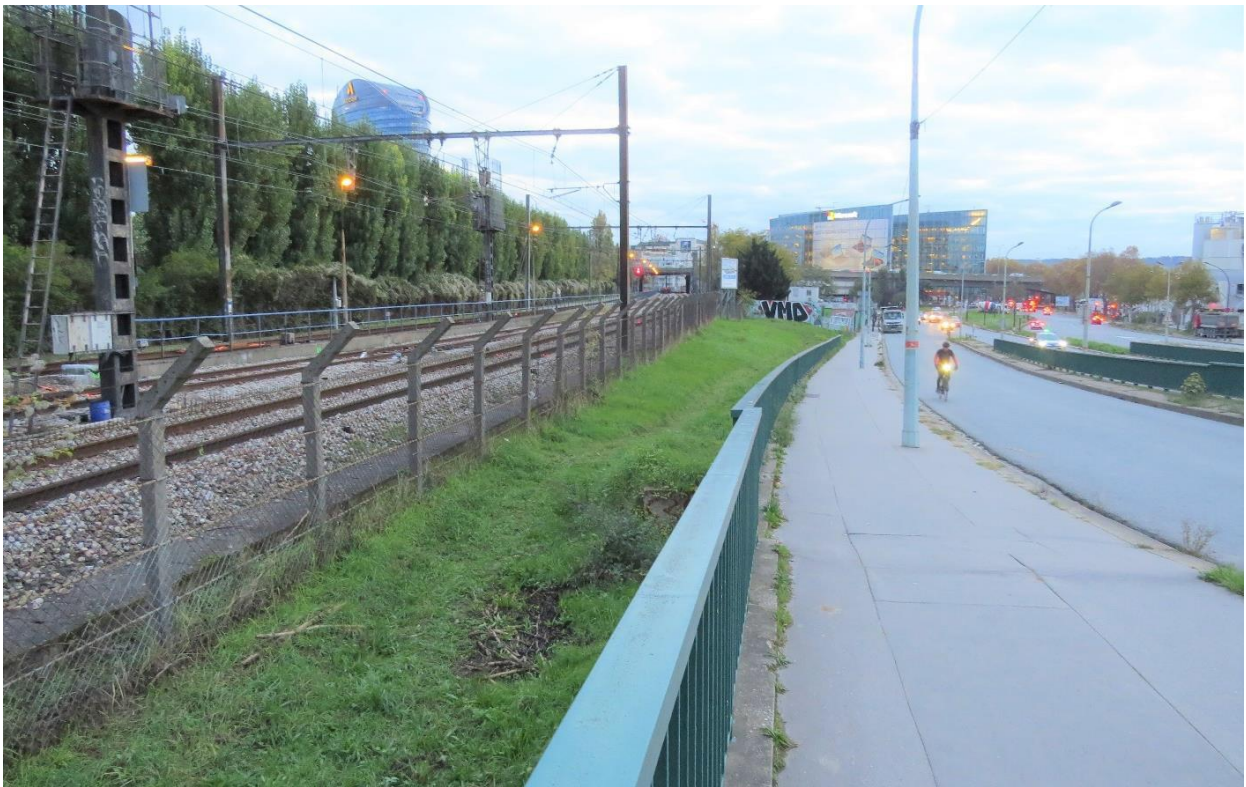
Photographie 7 : Vue du site et de la voie SNCF depuis le Quai d'Issy-les-Moulineaux, côté Pont du Garigliano
