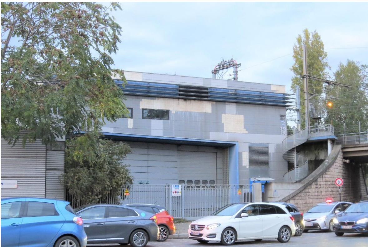
Photographie 2 : Poste transformateur situé au sud-est du site
