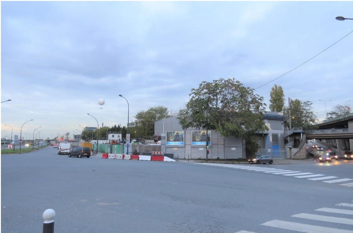
Photographie 1 : Vue du site et du poste transformateur depuis le quai D'Issy-les-Moulineaux, côté Boulevard Périphérique
