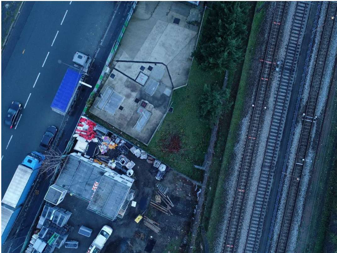
Photographie 21 : Vue drone n°5 du site
