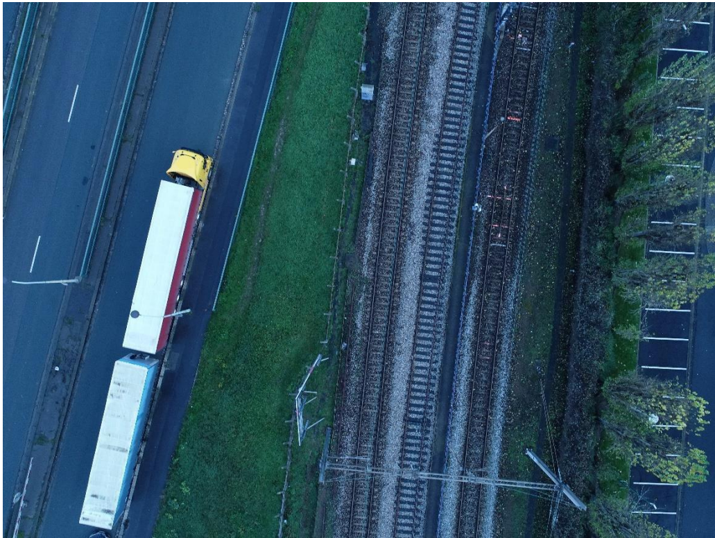
Photographie 23 : Vue drone n°7 du site
