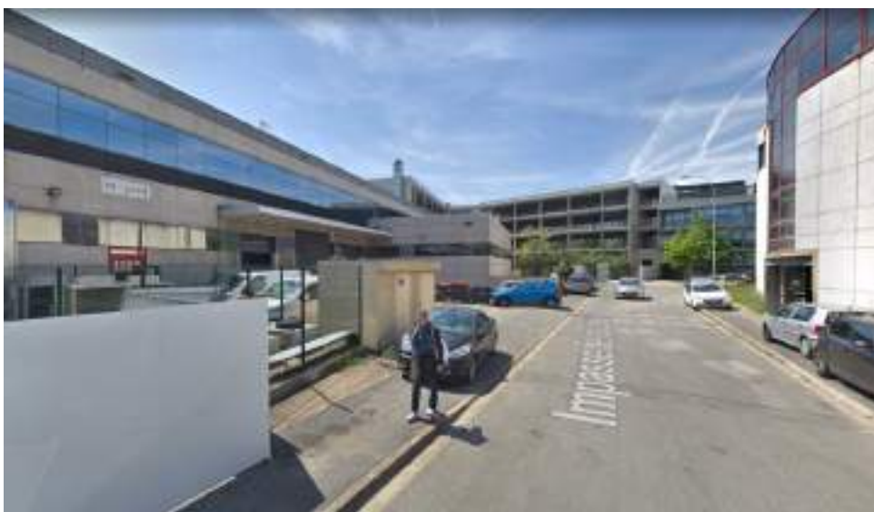
VUE 03 : Impasse de la Cokerie : Avril 2019
