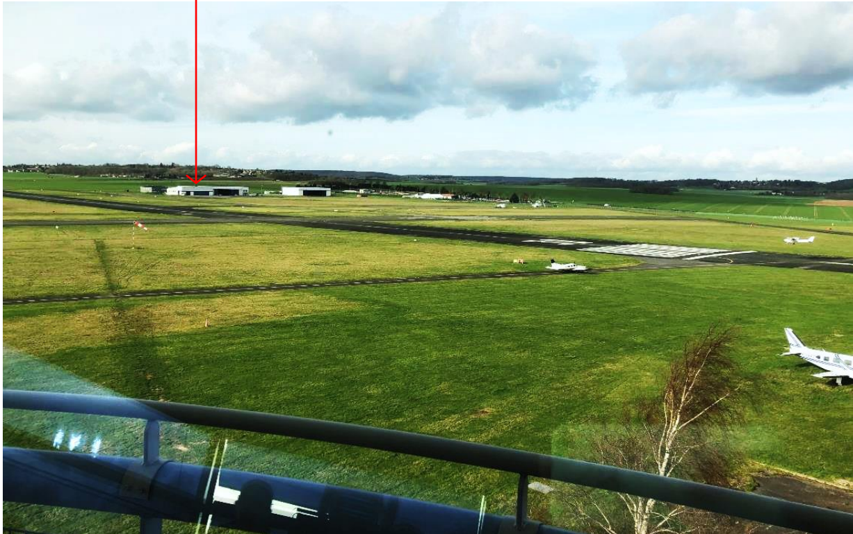
Photo 1 datée du 12/02/2020: 49°05'37'' N 2°02'35'' E (depuis la tour de contrôle de Pontoise)
