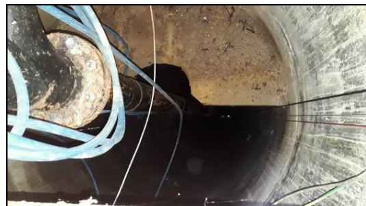
Photo 6 : Intérieur du puits
