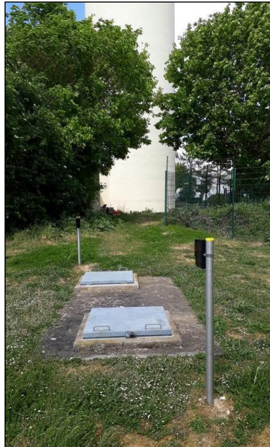
Photo 4 : Vue sur le forage
