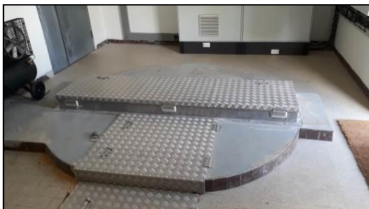
Photo 5 : Tête de puits
