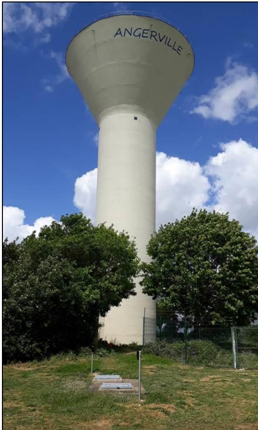
Photo 3 : Vue sur le château d'eau depuis le forage
