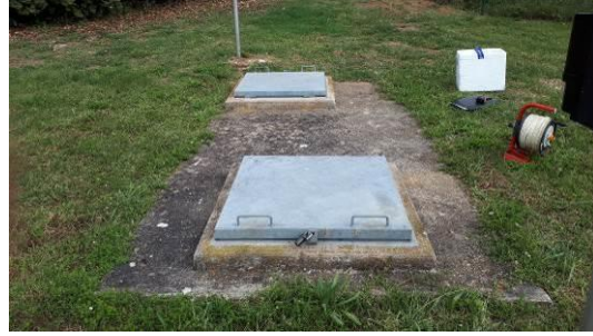
Photo 8 : Vue sur le forage
