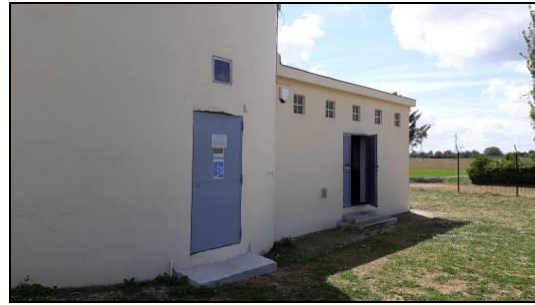
Photo 2 : Château d'eau et local du puits
