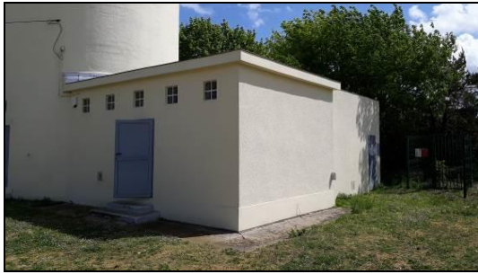
Photo 1 : Local technique contenant le puits
