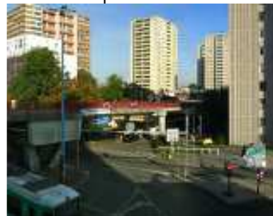
1. Vue sur la passerelle
