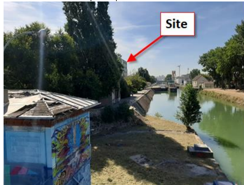
12 : depuis la passerelle au Nord du site (rive est du canal)
