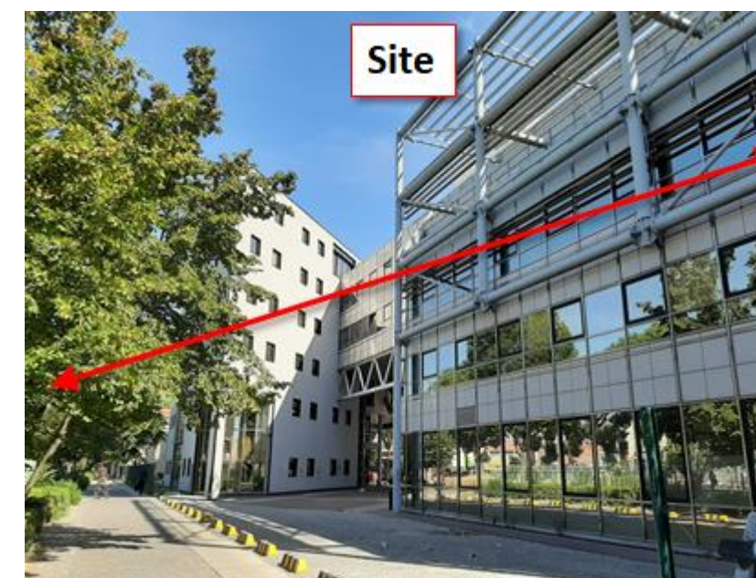
6 : depuis le canal Saint-Denis (sud du site)
