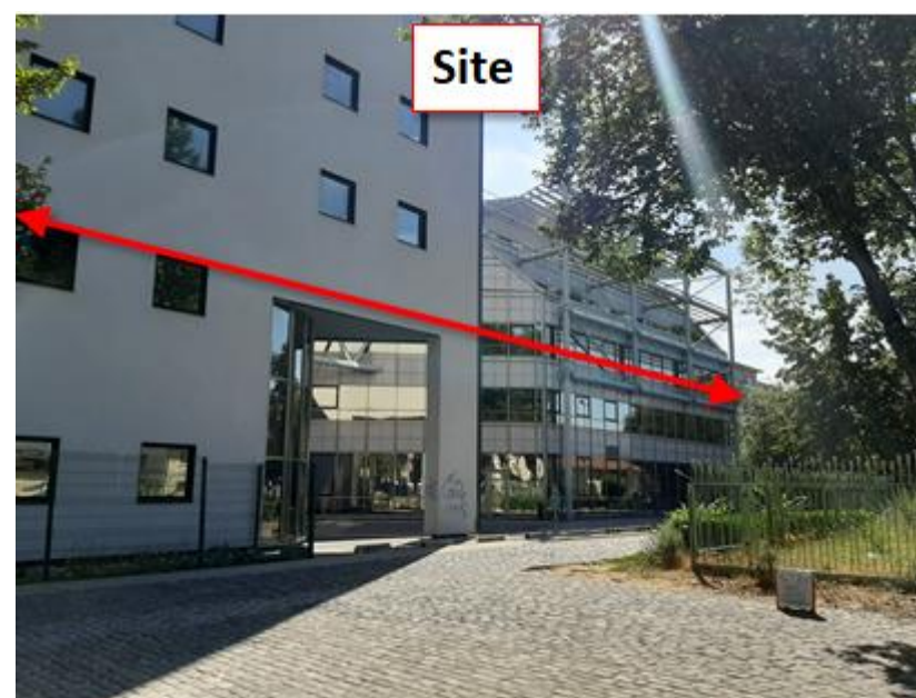
2 : depuis le canal Saint-Denis (nord du site)
