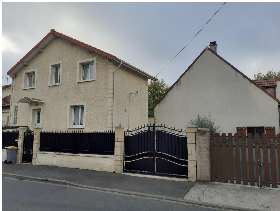
(9) Photographie 6 – vue extérieure de la zone d'étude depuis la rue Julien Victor
