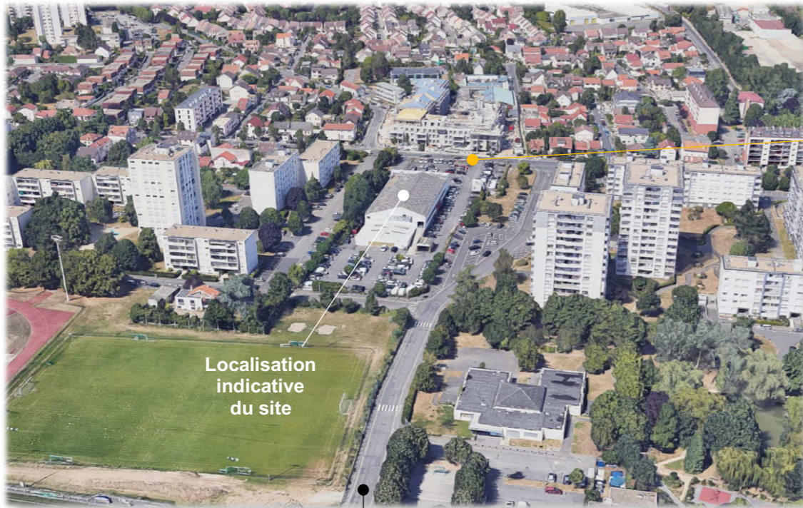
Vue en direction du Nord
