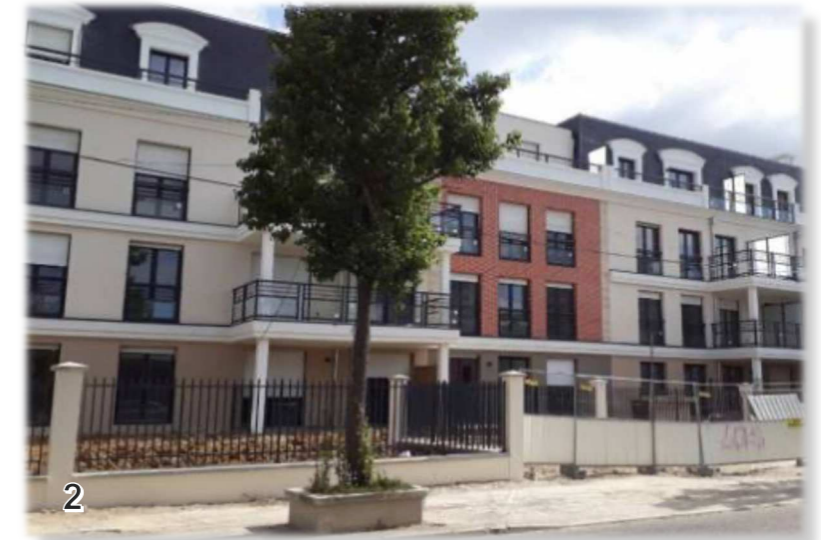
Vue sur l'ensemble résidentiel livré en Juillet 2020 en bordure de l'avenue du Maréchal FOCH (D30) au nord du site
