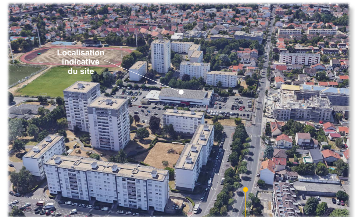
Vue en direction de l'Ouest
