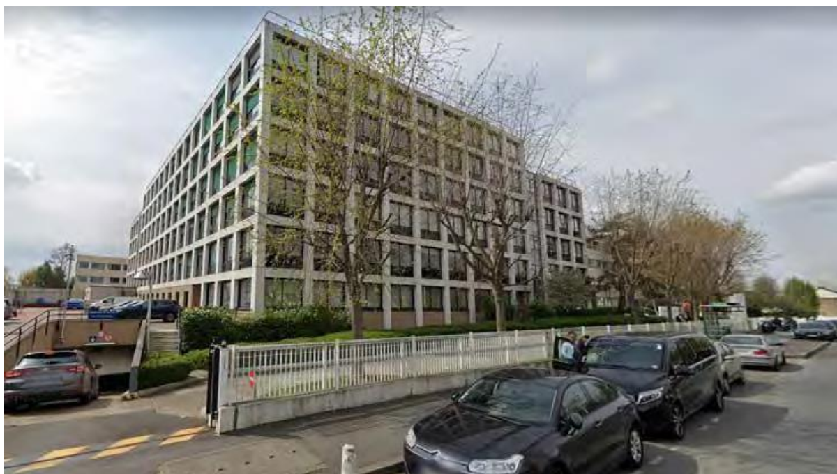
Photographie 1 : Vue depuis l'avenue Jules Quentin
