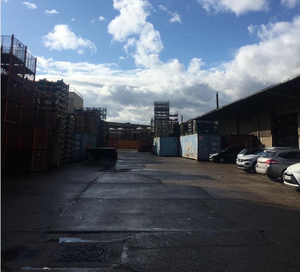
2 : Parking entrée principale
