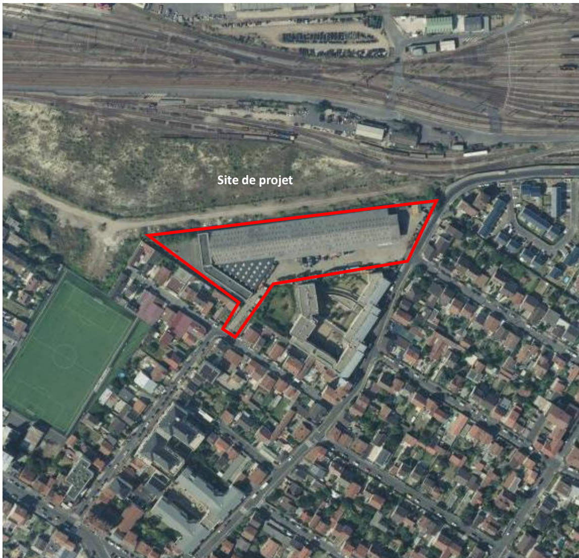
Vue aérienne du site, 2018 (Source : Géoportail). Echelle 1 : 4 264
