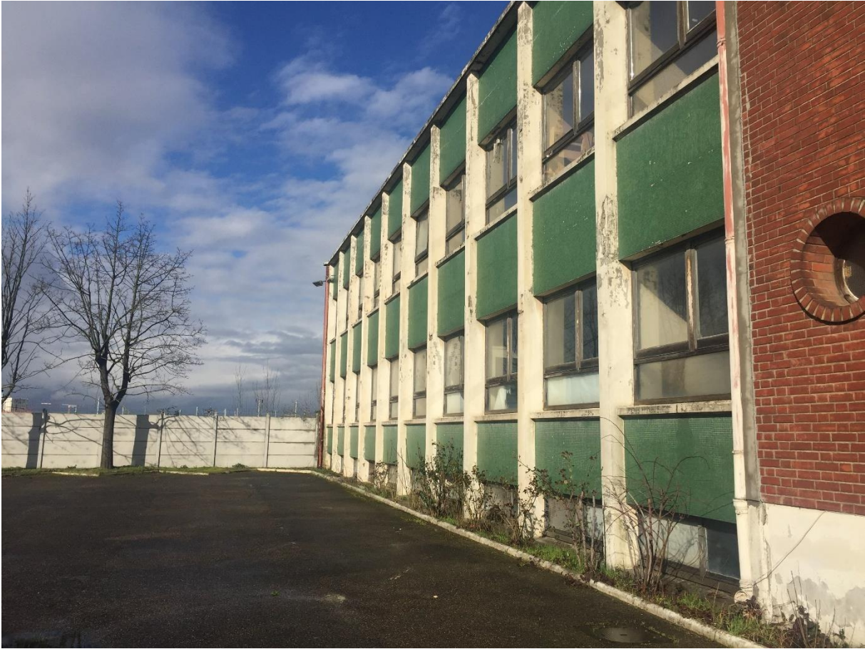
1 : Arrière du bâtiment
