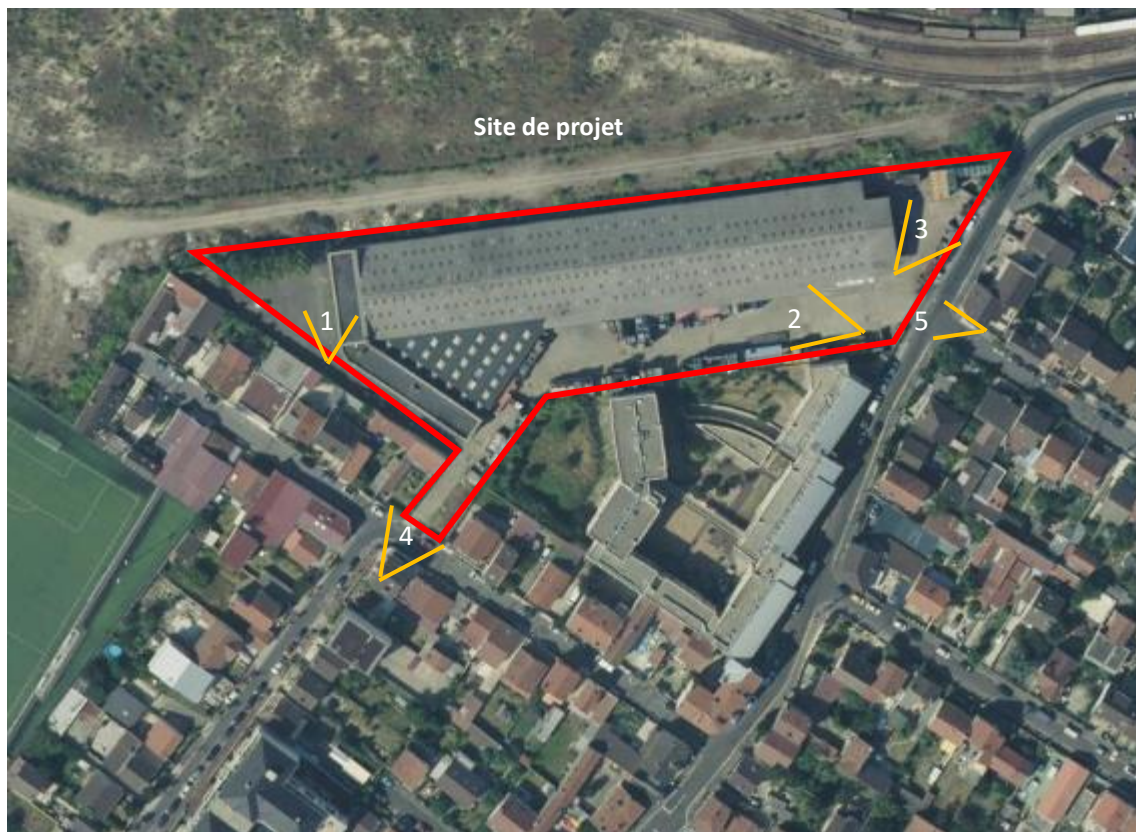
Vue aérienne du site, 2018 (Source : Géoportail). Echelle 1 : 3 000
