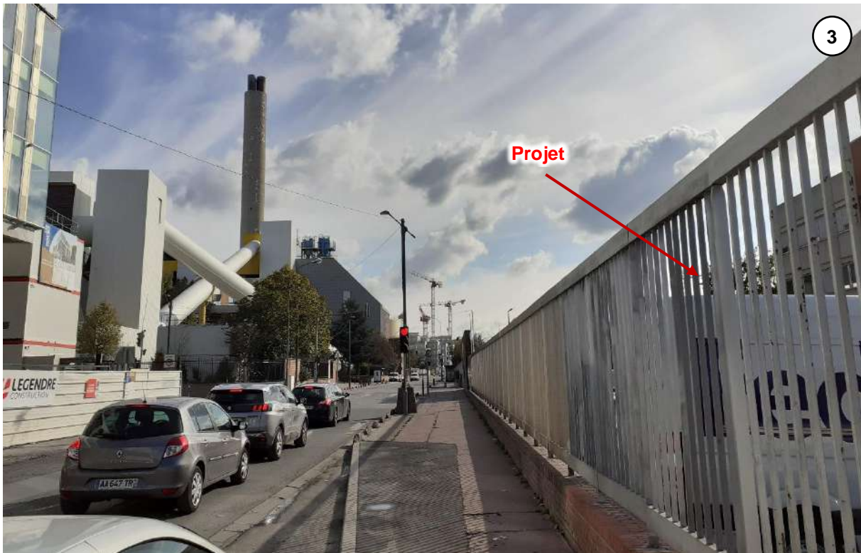
Figure 16 : Vue depuis la rue Ardoin, au niveau de la CPCU de Saint-Ouen
