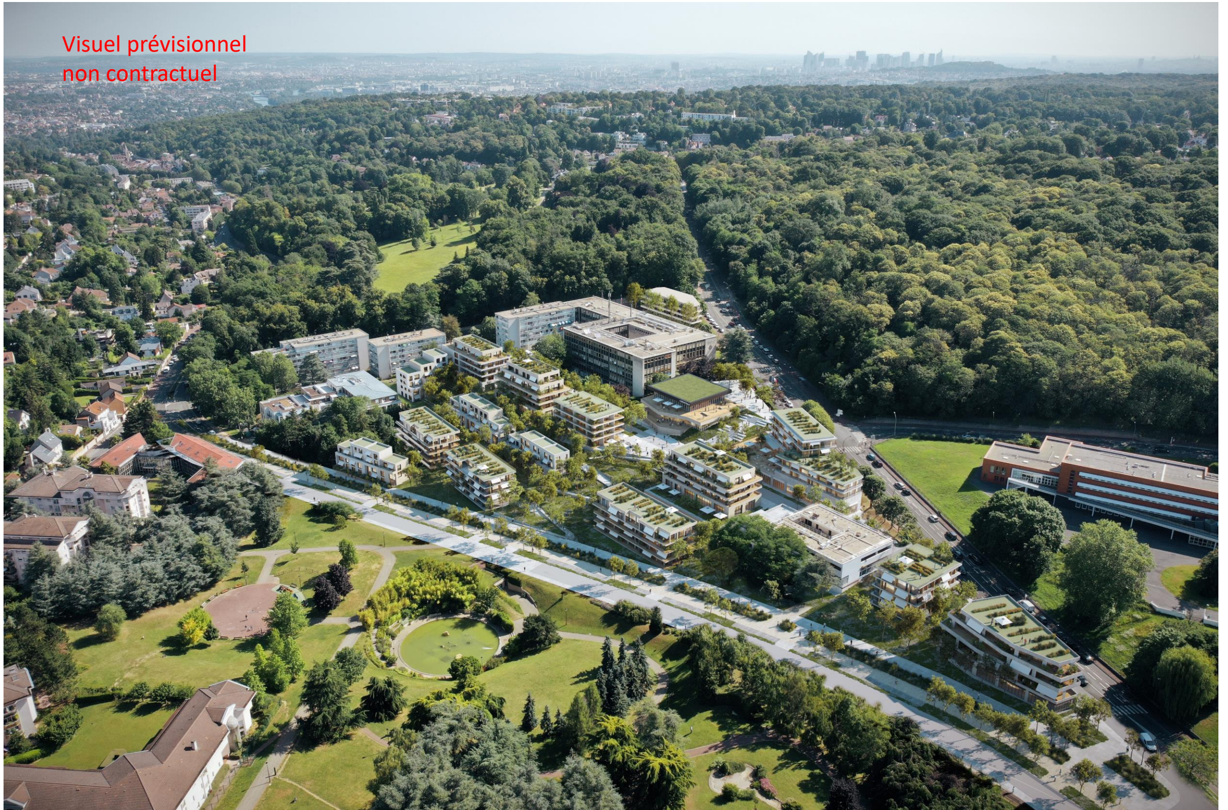
Vue aérienne de l'ensemble du projet
