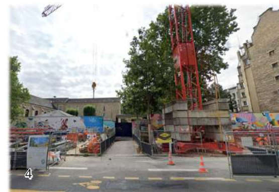
Vue sur le chantier en cours avenue Denfert Rochereau face au bâtiment Michèle Rapine
