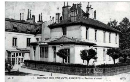
E. D., éditeur - Carte postale - Le pavillon de chirurgie orthopédique (anciennement Verneuil puis Jalaguier) au début du XX e siècle : façades sur la cour de service - Archive de l'Assistance Publique des Hôpitaux de Paris
