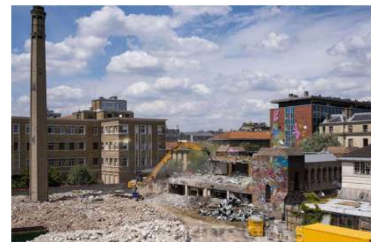
Déconstruction de la chaufferie de l'ancien hôpital Saint-Vincent-de-Paul
