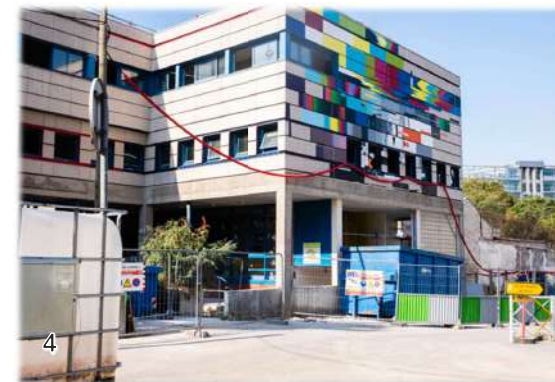
Vue sur le bâtiment de l'ancien centre de transfusion sanguine édifié dans le prolongement du bâtiment Michèle Rapine (déconstruction en cours)
