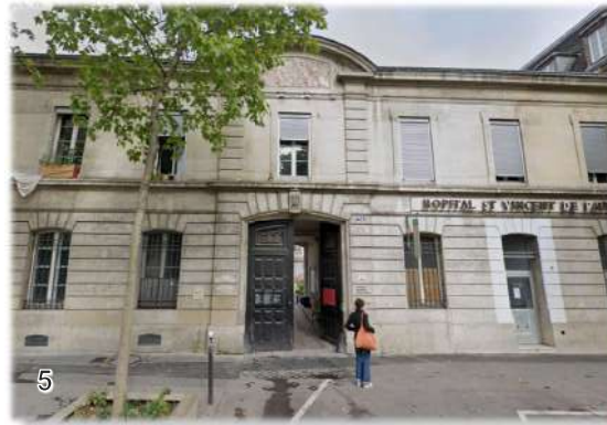
Vue sur l'accès piétons à la cour d'honneur du bâtiment Pierre Robin depuis l'avenue Denfert-Rochereau
