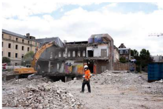
Déconstruction du bâtiment Antoine Colombani de l'ancien hôpital Saint-Vincent-de-Paul
