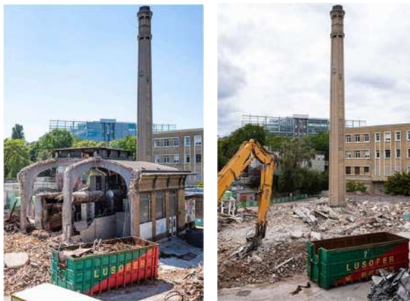
Déconstruction de la chaufferie de l'ancien hôpital Saint-Vincent-de-Paul
