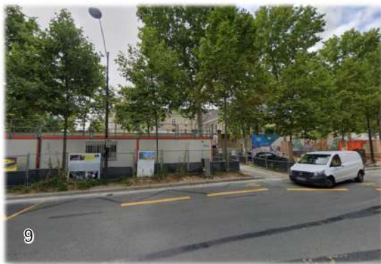
Vue sur le chantier en cours avenue Denfert Rochereau face au bâtiment Robin
