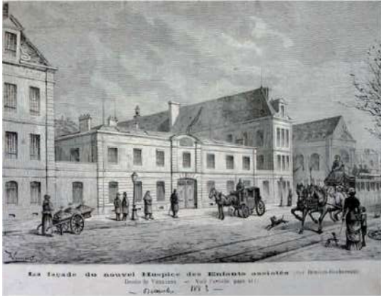
1883 - VERRIMT - GRAVEUR Hospice des enfants assistés : façade sur la rue Denfert-Rochereau des bâtiments Pierre Robin Musée Carnavalet, Cabinet des arts graphiques, 159D
