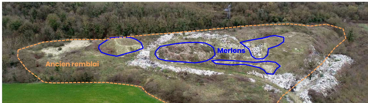
Figure 10 : Vue aérienne des merlons divers présents sur le remblai (vue prise par drone depuis l'ouest du site)
