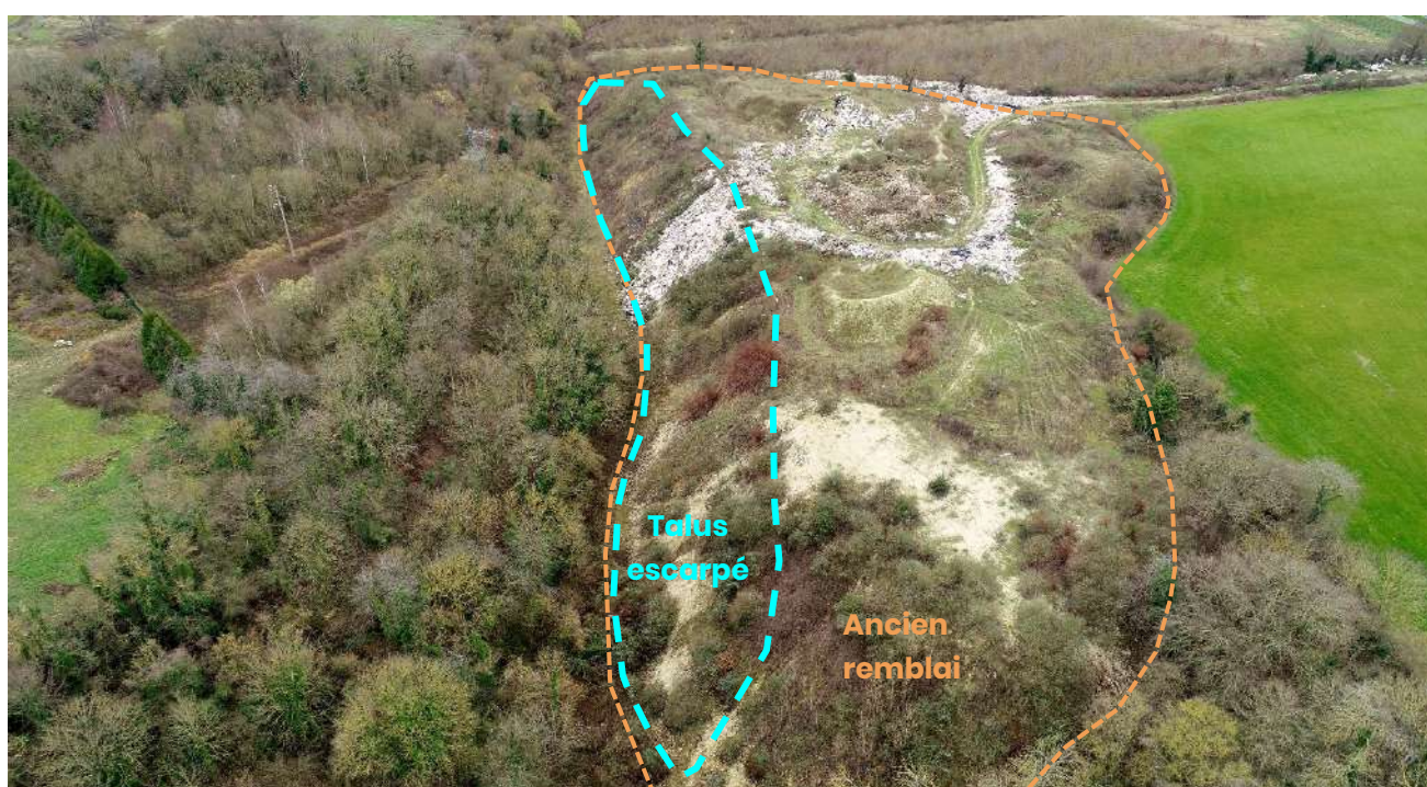
Figure 8 : Vue aérienne du talus escarpé situé à l'est du remblai (vue prise par drone depuis le nord du site)
