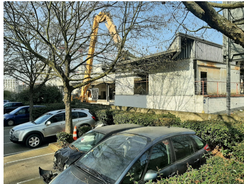
19 : démolition en vue de la construction de 162 logements sur 3 bâtiments
