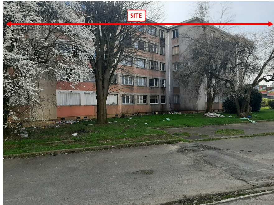
1 : le bâtiment ouest
