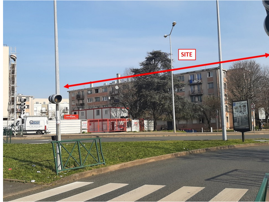
7 : depuis le parking Fitness Center au sud
