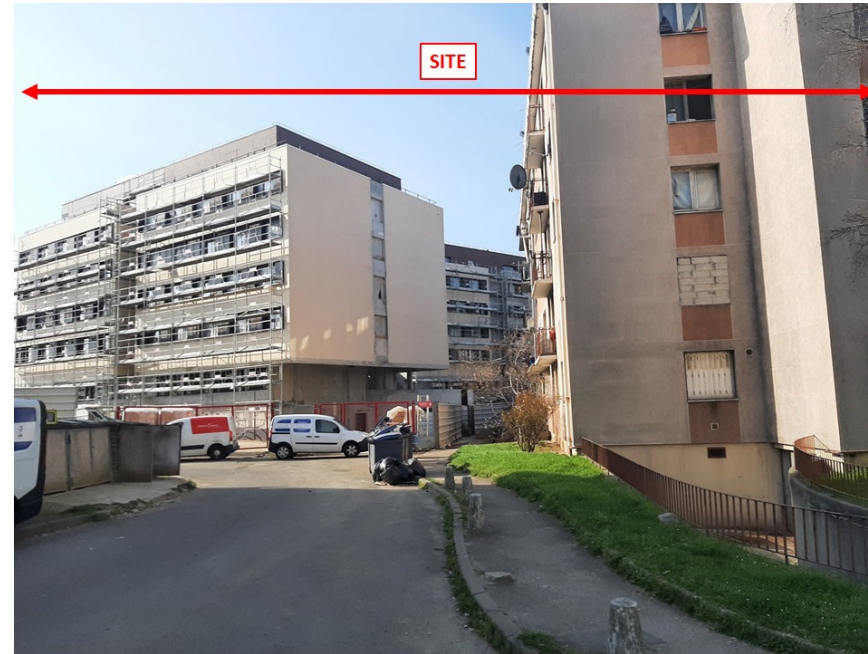
2 : le bâtiment central et les constructions voisines en cours
