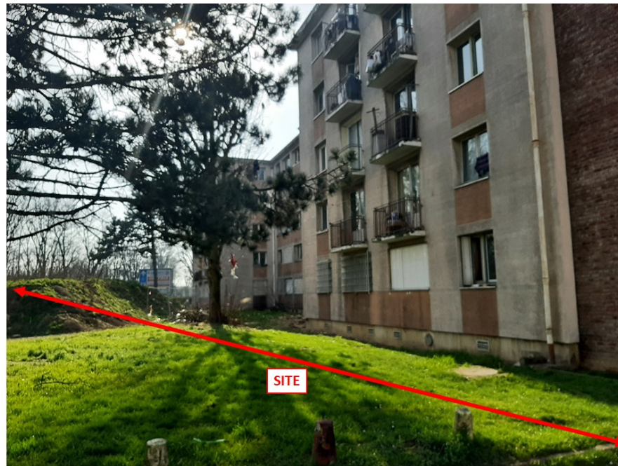
3 : le bâtiment est
