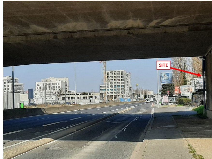
14 : depuis l'avenue de Fontainebleau au sud
