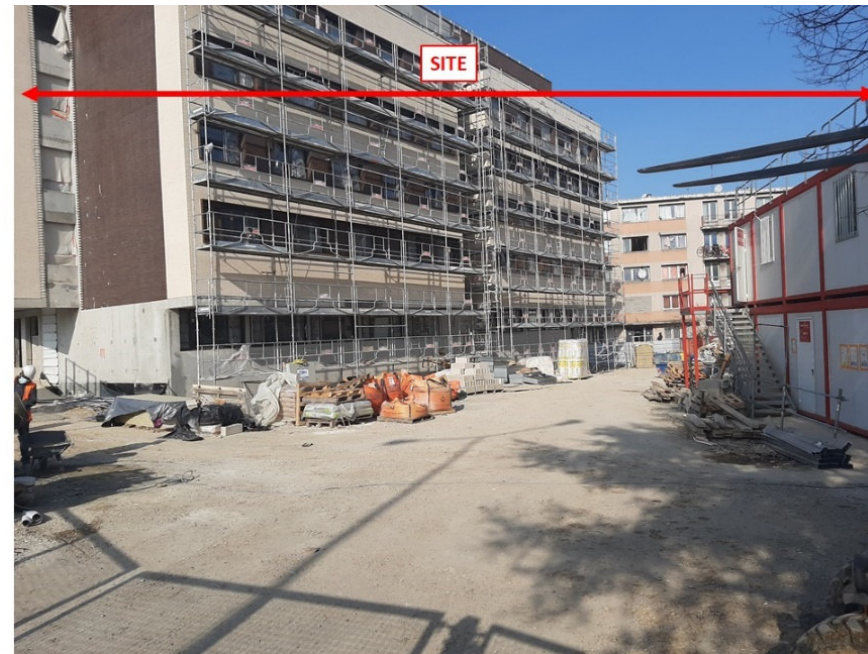
5 : le bâtiment central au fonds et les constructions voisines en cours
