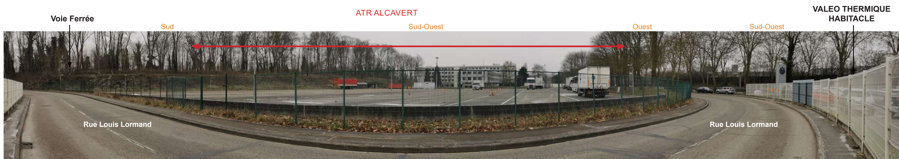
6 – VUE DEPUIS LA RUE LOUIS LORMAND, VERS LE SUD-OUEST. (PHOTO DU 09/02/2021)
