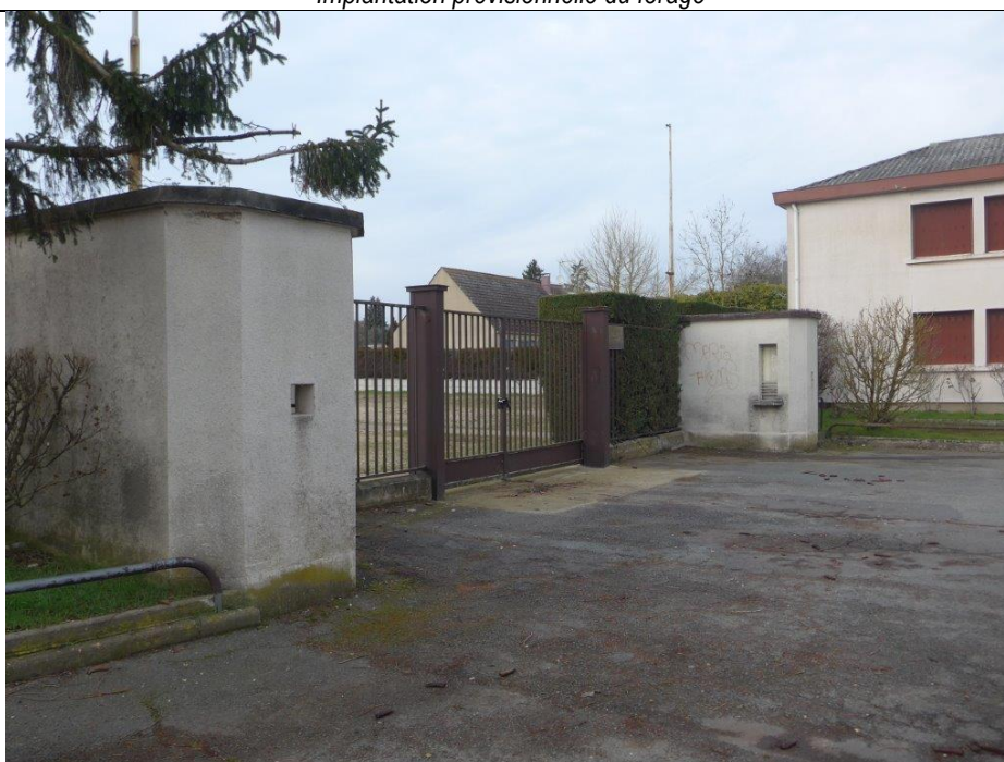
Entrée du stade
