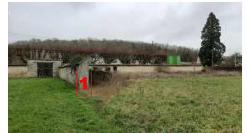
Démolition mur intérieur ancienne limite verger potager
