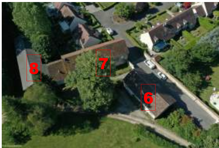
Démolition de l'ex-écurie, de l'ex-laiterie et du hangar agricole
