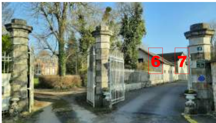
Démolition de l'écurie, de la laiterie Remplacement par mur bahut et grille métallique à l'identique de l'existant dans cette même rue
