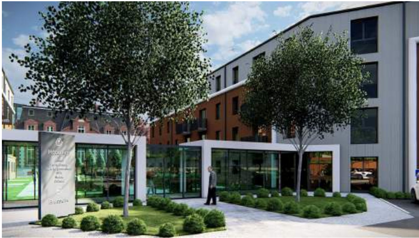
LE PASSAGE ENTRE LA PLACE DE LA RSS ET LA COUR EN DIRECTION DE LA MAISON LEVEQUE RECONVERTIE
