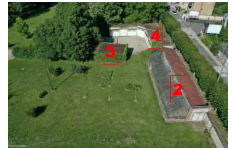
Démolition de l'ex-serre, de l'ex-sellerie et des ex-garages
