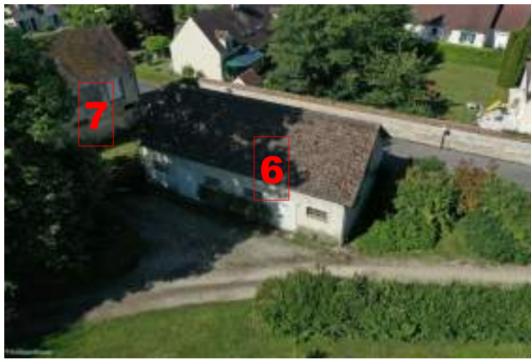
Démolition de l'ex-écurie et de l'ex-laiterie
