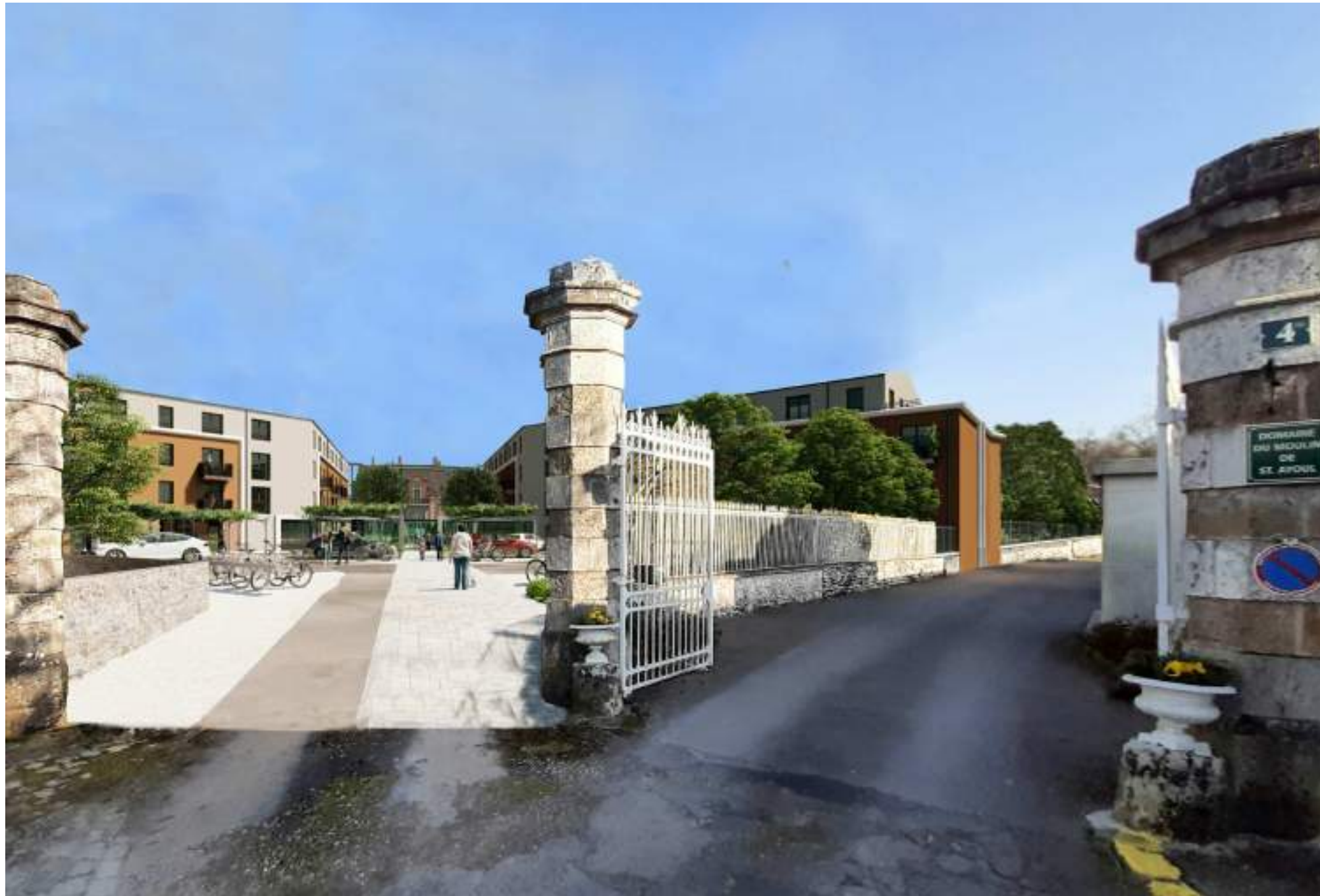
L'ENTREE DEPUIS L'AVENUE DE LA LIBERATION = PORTAIL DE GAUCHE A DROITE LA RUE PRIVATIVE DE LA RESIDENCE DU MOULIN DE ST AYOUL AVEC L'AILE B EN PERSPECTIVE
