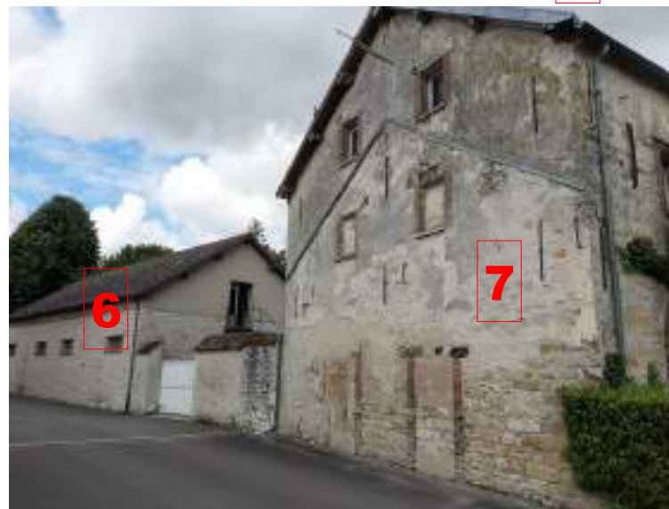
Déconstruction de l'ex-laiterie, trie des pierres pour réutilisation
