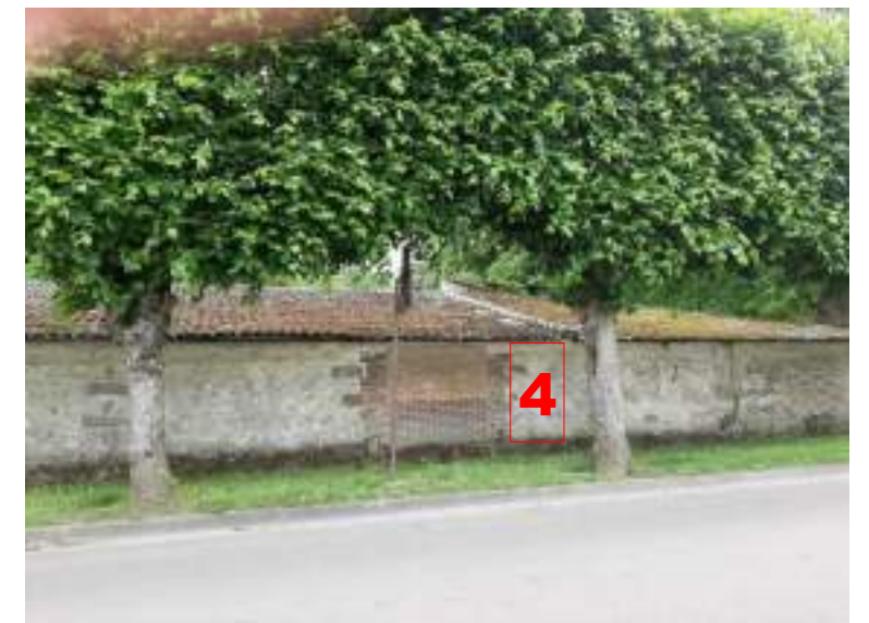
Démolition des ex-garages pour création accès B+C
