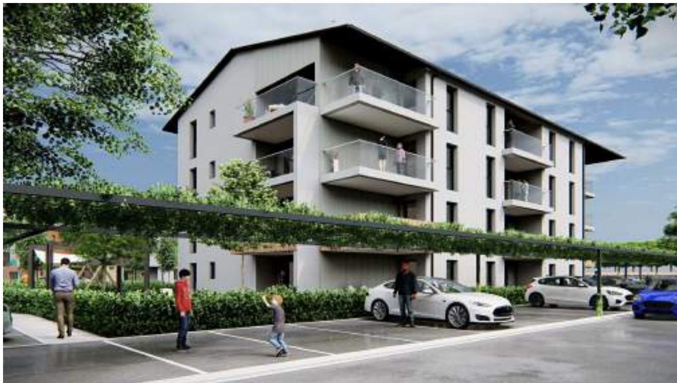
LE TRAVAIL DES PERGOLAS POUR INTEGRER PLUS FAVORABLEMENT LES PARKINGS DANS L'ESPACE DU PARC
