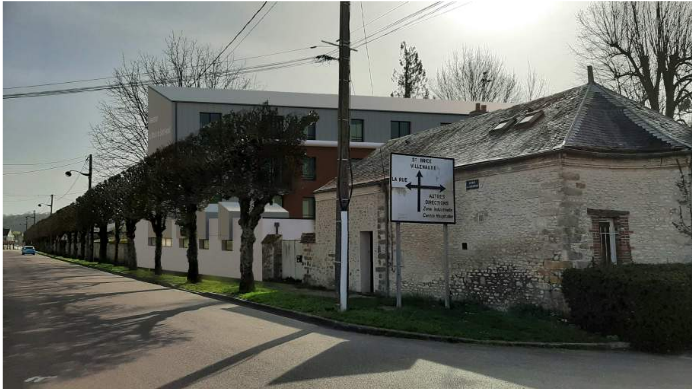
VUE SUR L'AVENUE DE LA LIBERATION AVEC BATIMENT EXISTANT D'ENTREE DE SITE AU PREMIER PLAN (direction vers St Brice)
