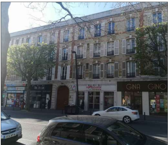
Photo n.4 Début de la rue E. Renault avec ses bureaux commerce et logements
