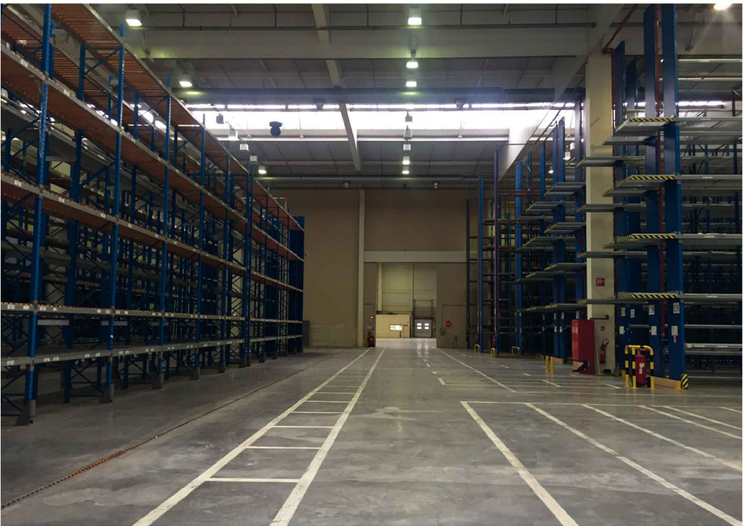
1.VOLUME DE STOCKAGE
